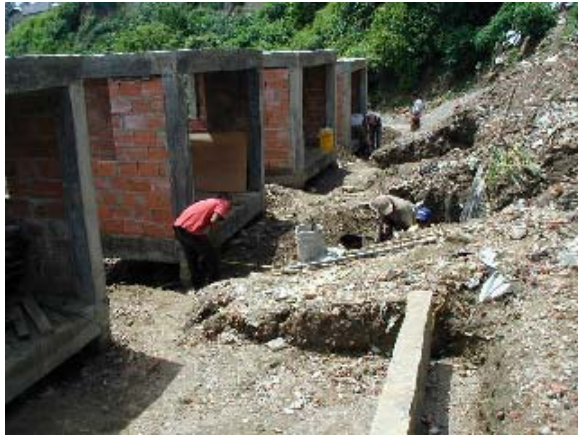
Foto 3.5.48 Muro de Contención
