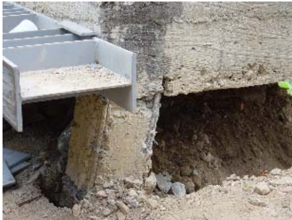
Foto 3.5.56 Modelo 1-Falla de Columna Corta (1)
