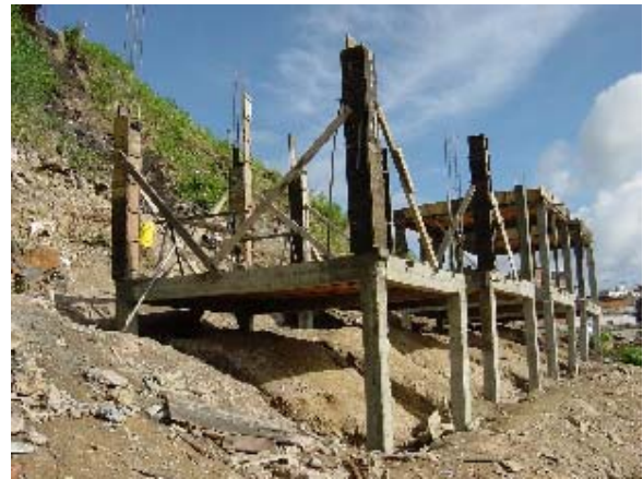
Foto 3.5.39 Encofrado de Columnas (2)
