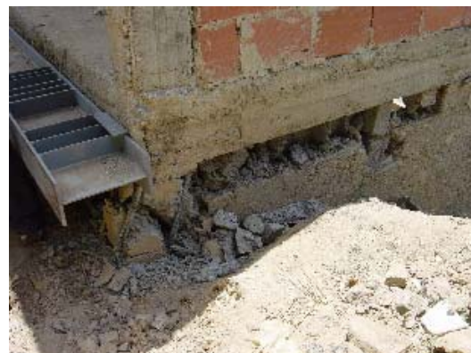
Foto 3.5.73 Falla de Columna y Muro de Bloques de Concreto
