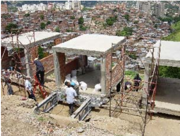
Foto 3.5.54 Equipo de Medición (1)
