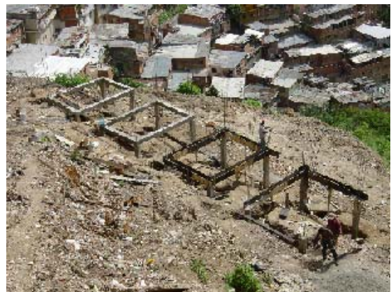
Foto 3.5.9 Construcción de Vigas
