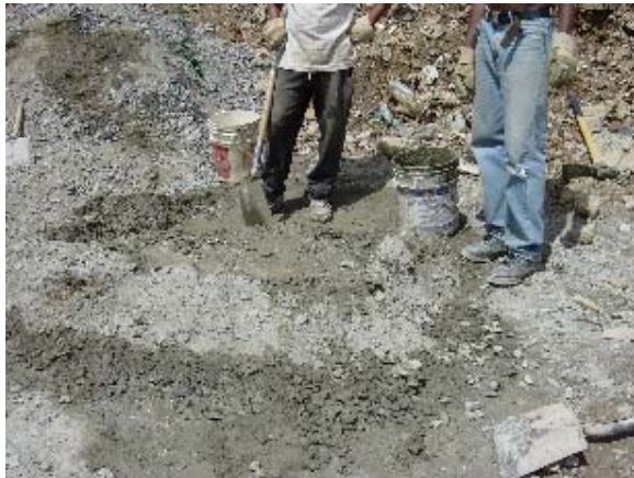
Foto 3.5.14 Mezcla del Concreto
