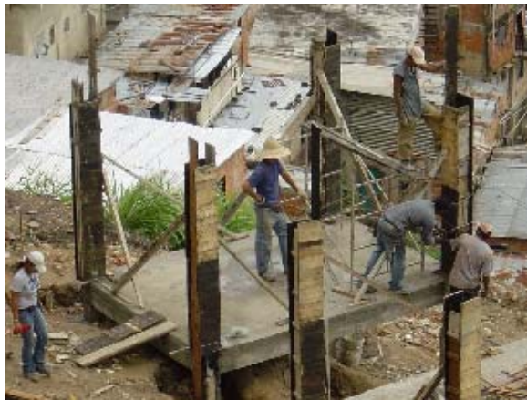
Foto 3.5.38 Encofrado de Columnas (1)
