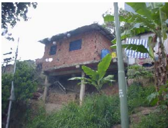
Foto 3.5.4 Vivienda de Barrio en Pendiente (1)
