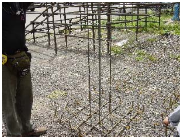
Foto 3.5.18 Instalación de Cabillas(1)
