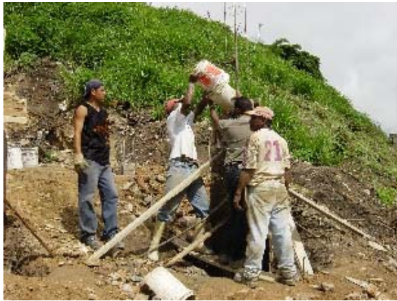
Foto 3.5.30 Vaciado Columna Larga
