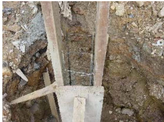
Foto 3.5.25 Encofrado Columna Corta (2)
