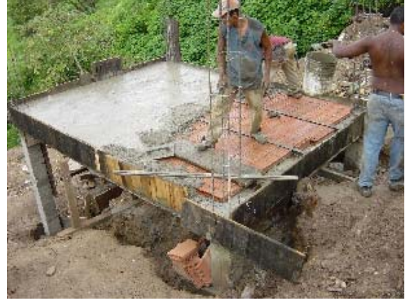
Foto 3.5.37 Piso de Tabelone y Vaciado
