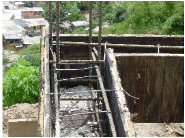
Foto 3.5.33 Instalación Cabillas de Viga
