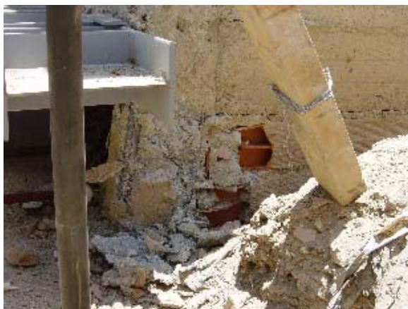
Foto 3.5.68 Falla de Corte de Columna Muro de Bloque de Arcilla (1)
