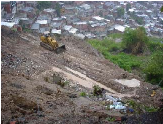
Foto 3.5.6 Movimiento de Tierra
