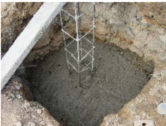
Foto 3.5.22 Vaciado del Concreto de Fundación
