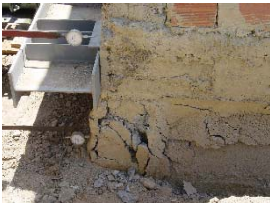
Foto 3.5.74 Falla por Corte de Columna y Muro de Bloques de Conc. c/Cabillas (1)
