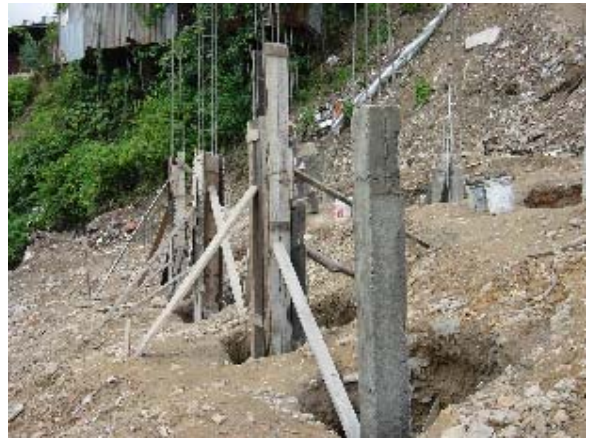
Foto 3.5.31 Concreto Columna Larga
