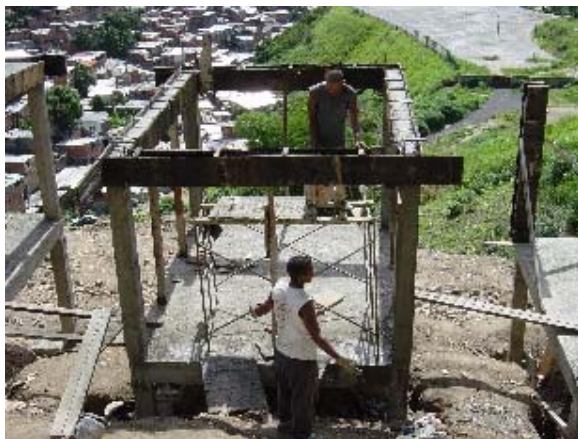
Foto 3.5.38 Encofrado de Columnas (1)
