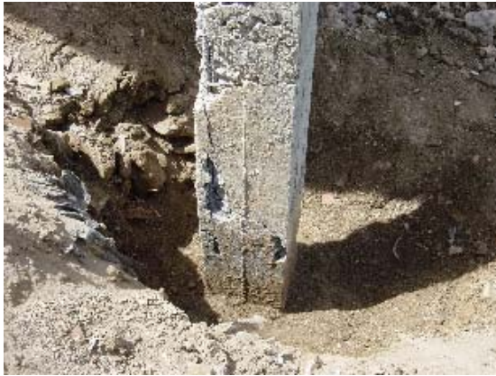
Foto 3.5.64 Modelo 2- Falla de Columna Larga (2)
