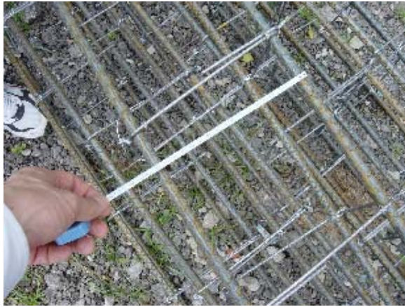
Foto 3.5.18 Instalación de Cabillas(1)
