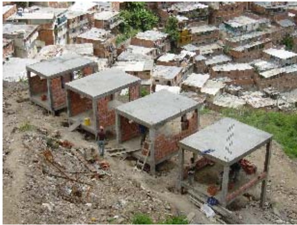
Foto 3.5.12 Construcción de Techos
