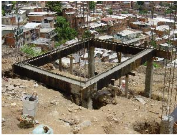
Foto 3.5.32 Viga de Piso
