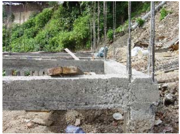
Foto 3.5.35 Remoción del Encofrado
