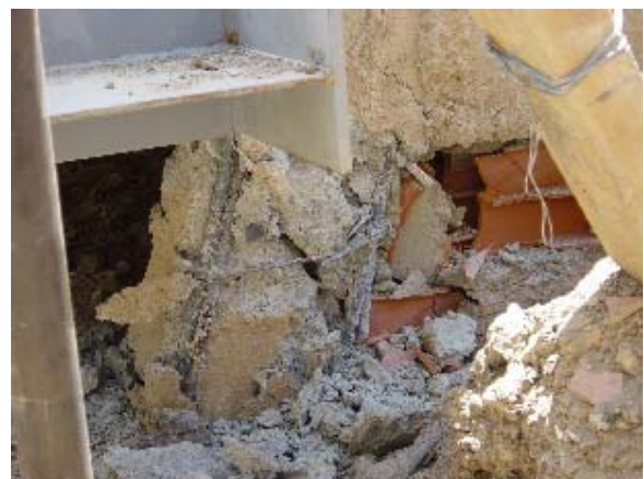
Foto 3.5.68 Falla de Corte de Columna Muro de Bloque de Arcilla (1)
