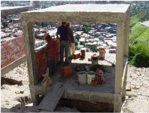
Foto 3.5.42 Constr. Muro de Arcilla (1)
