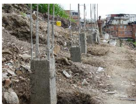
Foto 3.5.27 Concreto Columna Corta (1)
