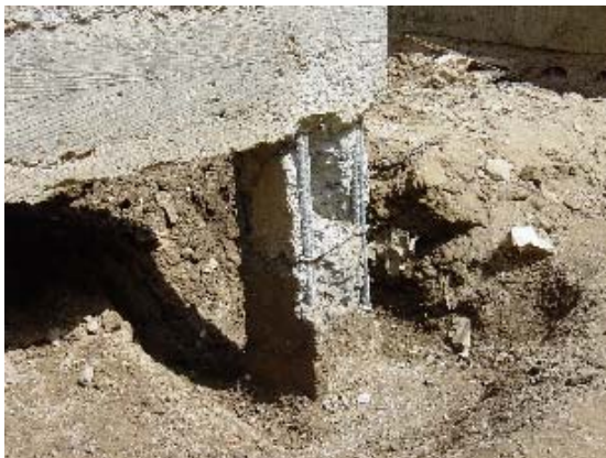
Foto 3.5.62 Modelo 2- Falla por Corte de Columna Corta (2)
