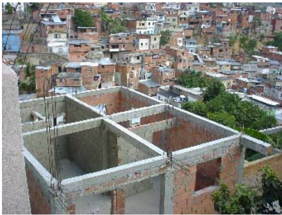
Foto 3.5.3 Una Vivienda de Barrio en Construcción
