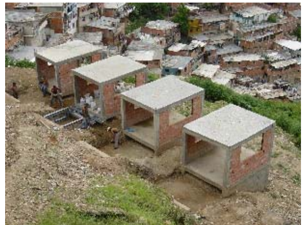
Foto 3.5.13 Construcción de Paredes
