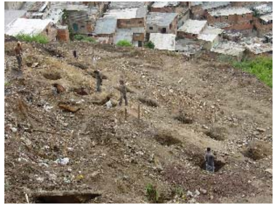
Foto 3.5.7 Trabajos de Excavación
