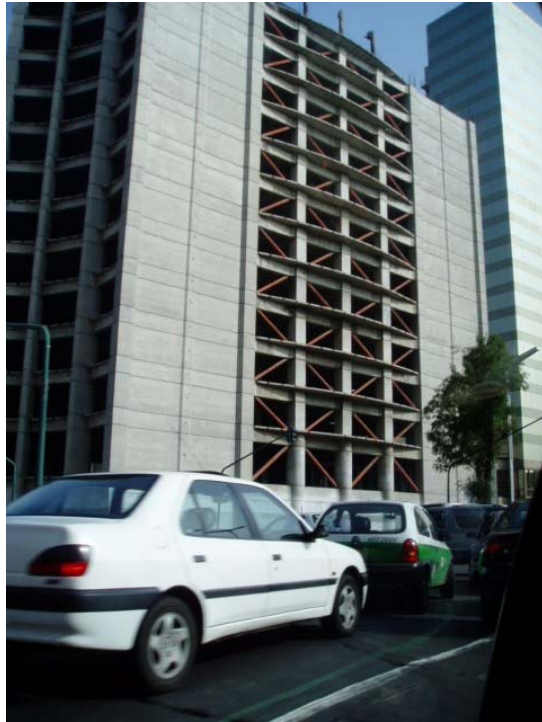
Figura 3.5.24 Ejemplo de Refuerzo con Arrostramiento de Acero
