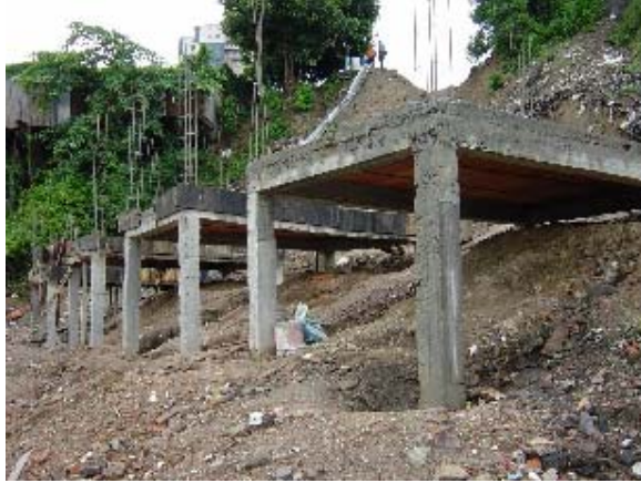
Foto 3.5.36 Columnas Largas y Pisos
