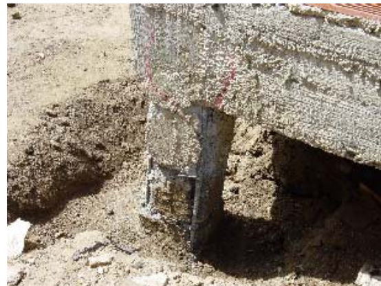
Foto 3.5.62 Modelo 2- Falla por Corte de Columna Corta (2)
