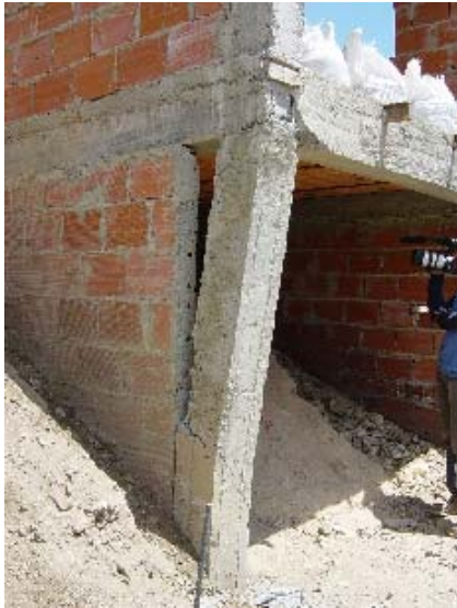
Foto 3.5.70 Separación del Muro y el Pórtico
