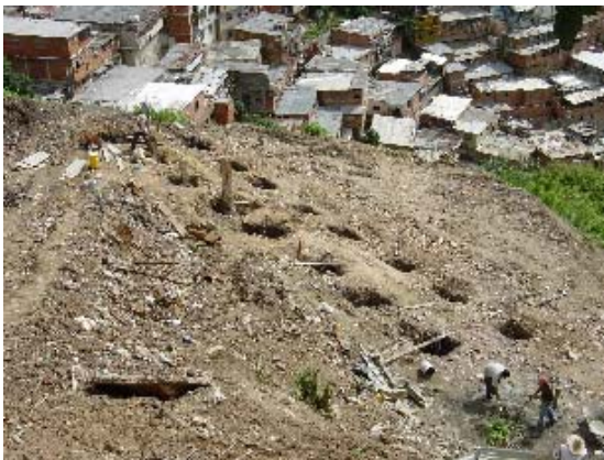
Foto 3.5.8 Construcción de Columnas
