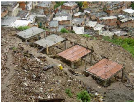
Foto 3.5.10 Construcción de Pisos
