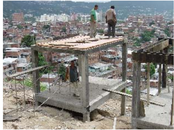
Foto 3.5.39 Encofrado de Columnas (2)
