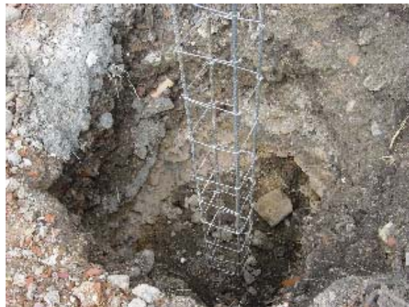
Foto 3.5.21 Excavación para la Fundación
