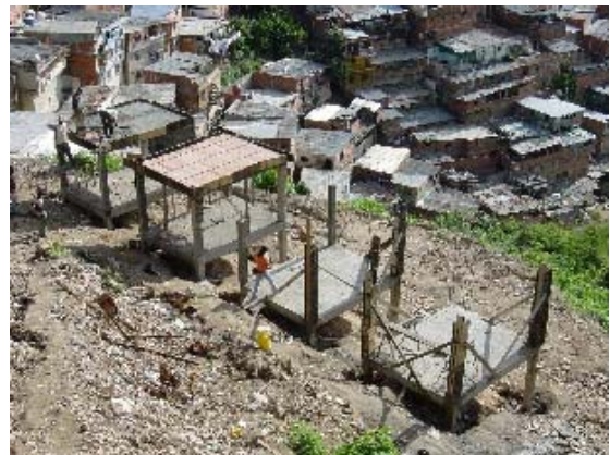
Foto 3.5.11 Construcción de Columnas
