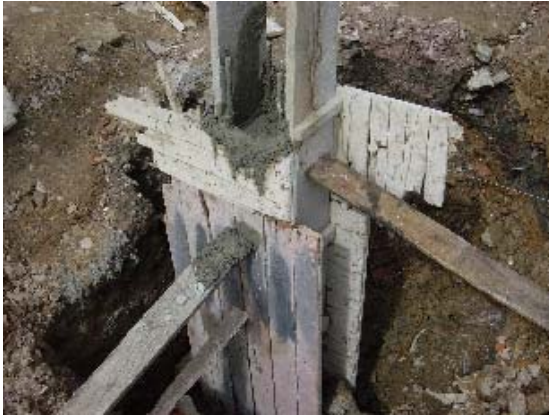
Foto 3.5.24 Encofrado Columna Corta (1)
