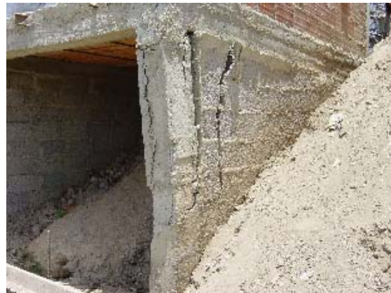
Foto 3.5.72 Separación de Muro de Bloques de Concreto sin Cabillas del Pórtico
