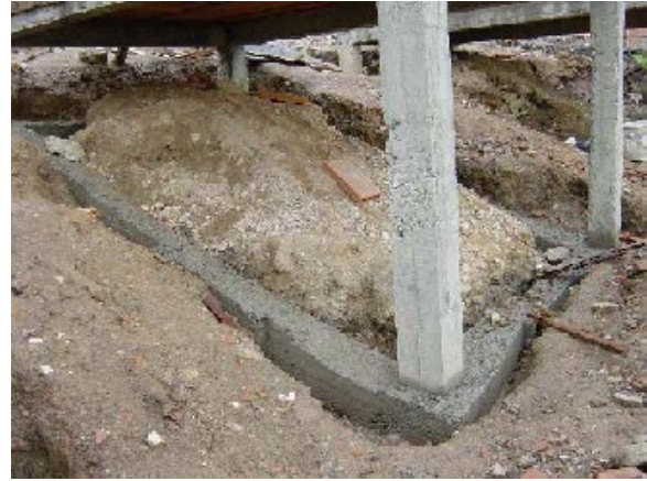
Photo 3.5.2 Viga de Carga
