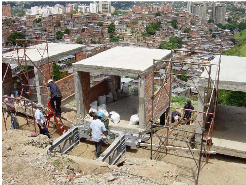
Photo 3.5.3 Cargado Horizontal por Gato Hidráulico
