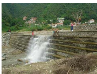
San Jose de Galipan 川既設砂防ダム
