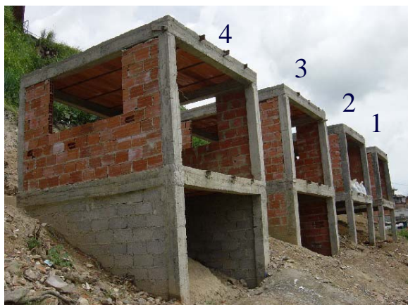
写真 3.5.1 試験を実施した4モデルハウス
