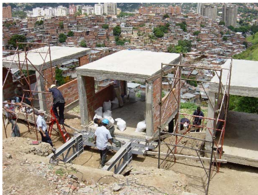
写真 3.5.3 油圧ジャッキによる水平載荷
