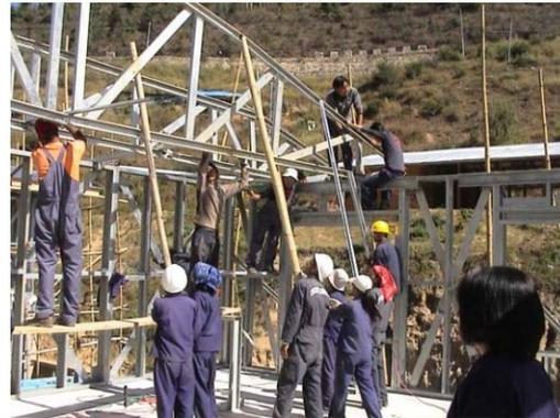
LGSF屋根トラス設置工事中
