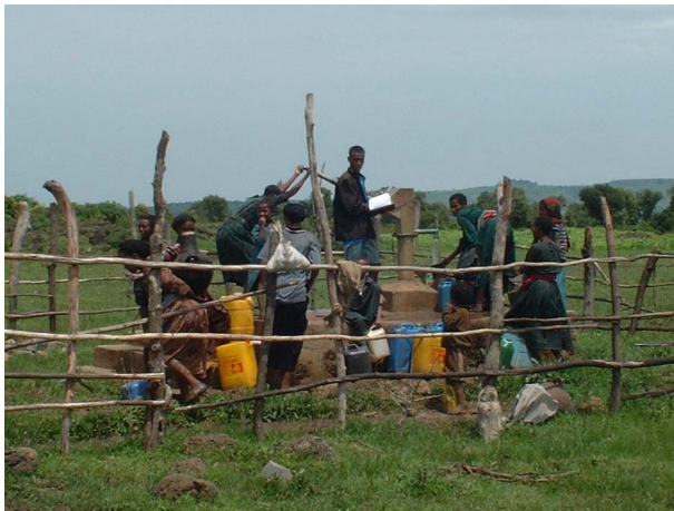
既存ハンドポンプ給水施設
