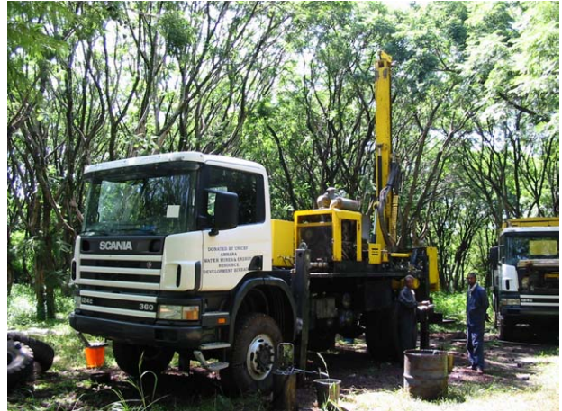
既存井戸掘削リグ (R50)
