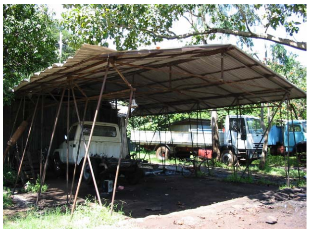
資機材・車両修理作業所
