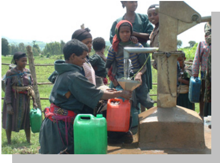
ハンドポンプ給水施設
