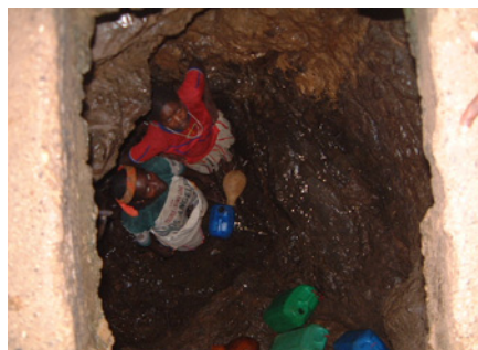
既存給水施設（手掘り井戸）
