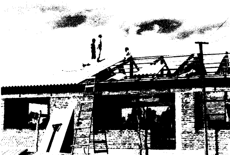
人工授精棟の屋根 スレート取付け工
