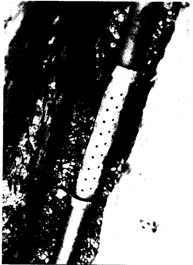
浸透用穴有管の埋設状況
