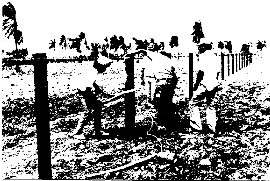
有刺鉄線柵取付け状況
