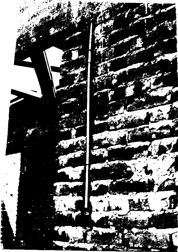
家畜衛生検査棟の 電線管理設状況
