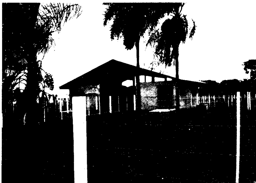
北西から見た状況
