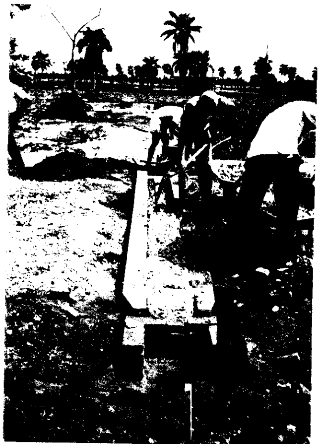
道路横断の排水管工
