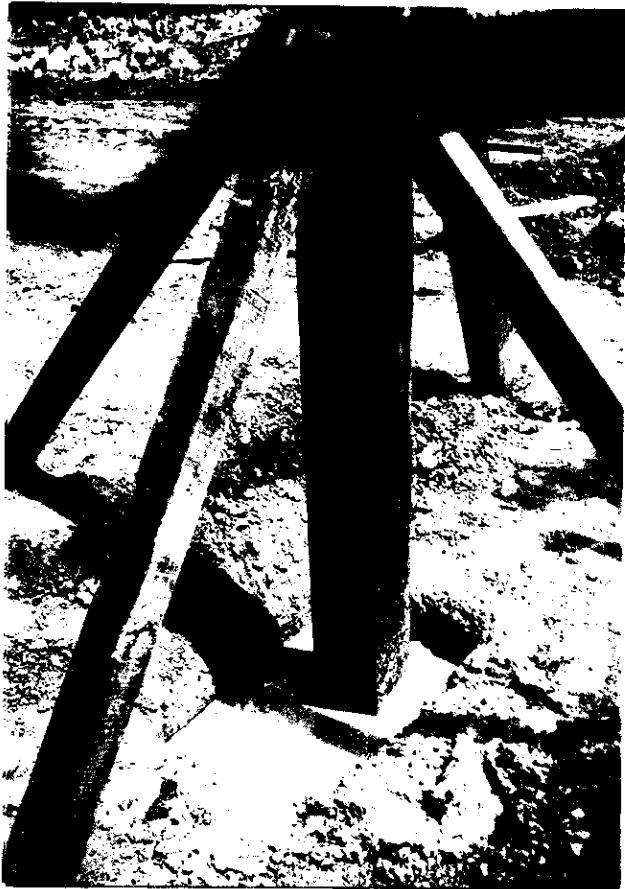
ゲート用柱基礎 コンクリート流し工
