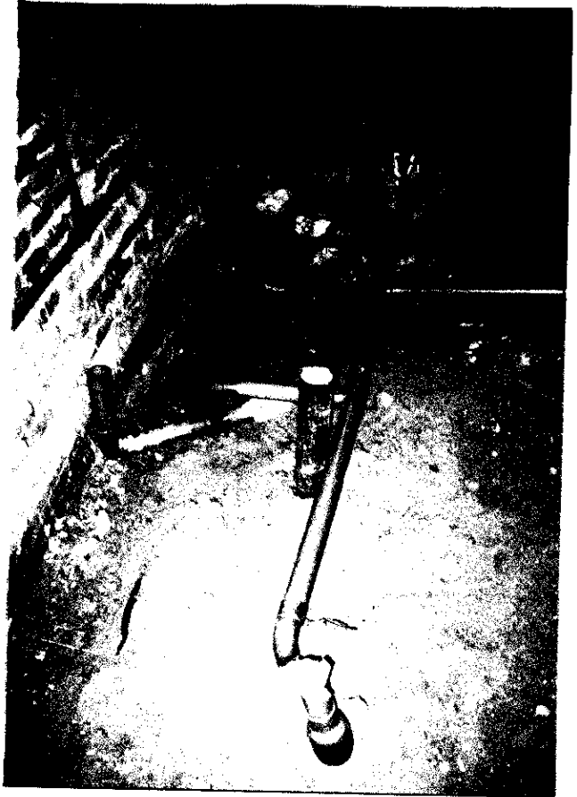
家畜衛生検査棟の 給排水管理設状況
