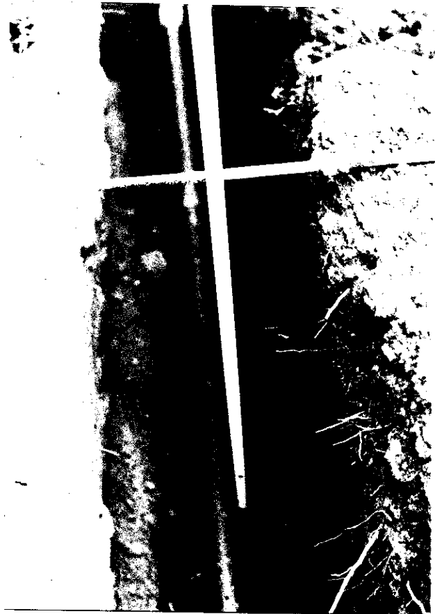
給水管の埋設状況
