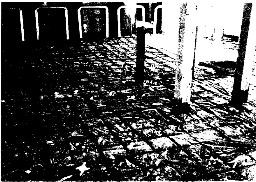
人工授精棟の採精室の 土間鉄筋コンクリート工
