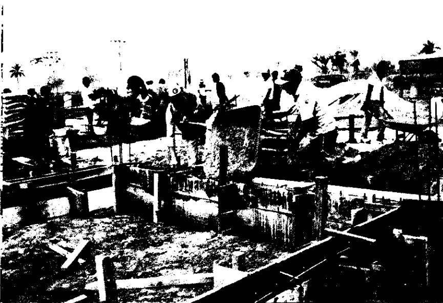
人工授精棟の基礎 コンクリート工（300 リター のコンクリートミクサー使用）
