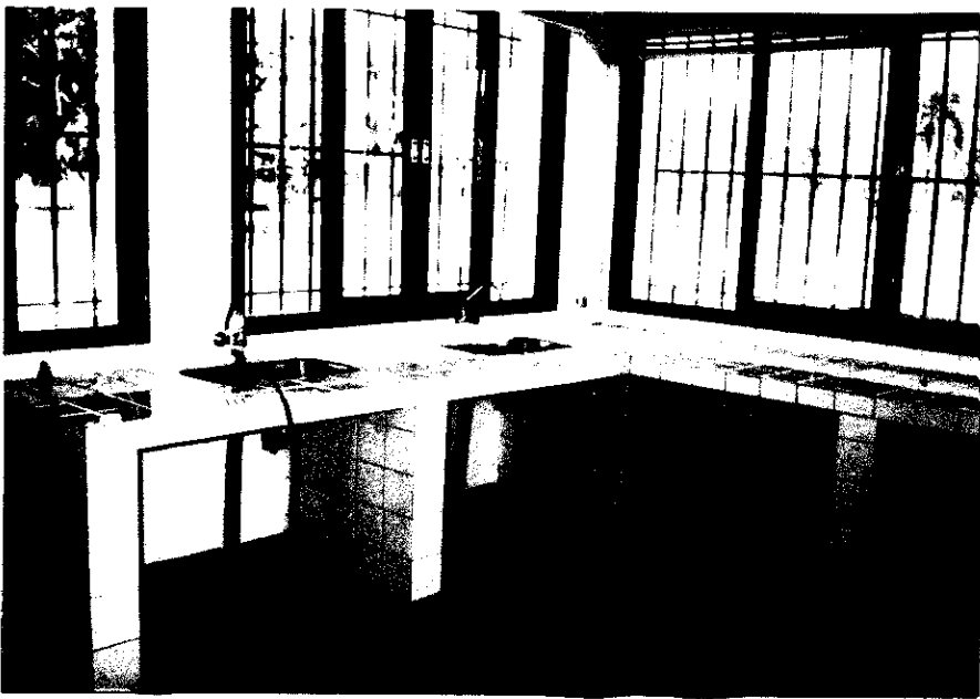
家畜衛生検査棟の消毒・滅菌室
