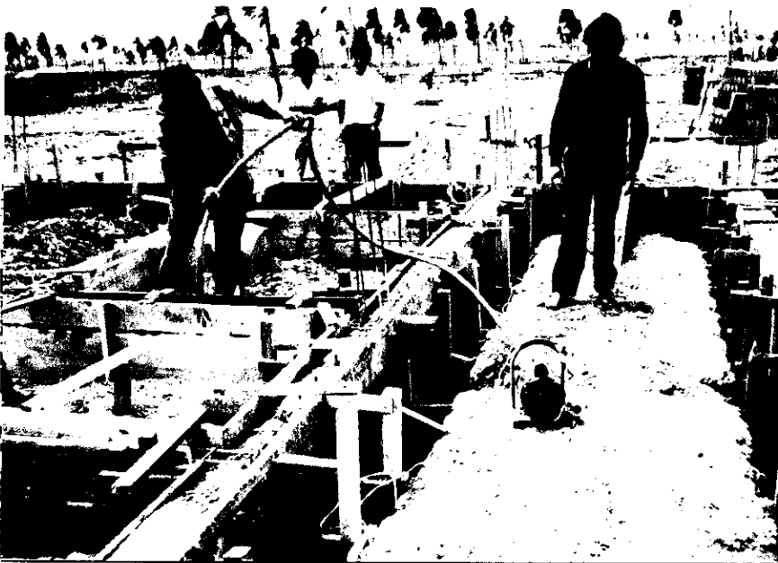
家畜衛生検査棟の基礎 コンクリート工（バルブ レーターの使用状況）
