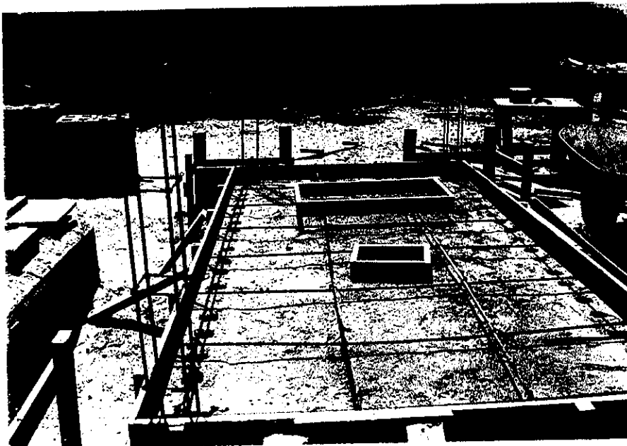
生活雑排水処理施設の 送風器及び放流ポンプ 場の基礎鉄筋コンクリ ート工
