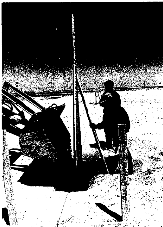
主垂鉛引鉄パイプ柱 据え付け工
