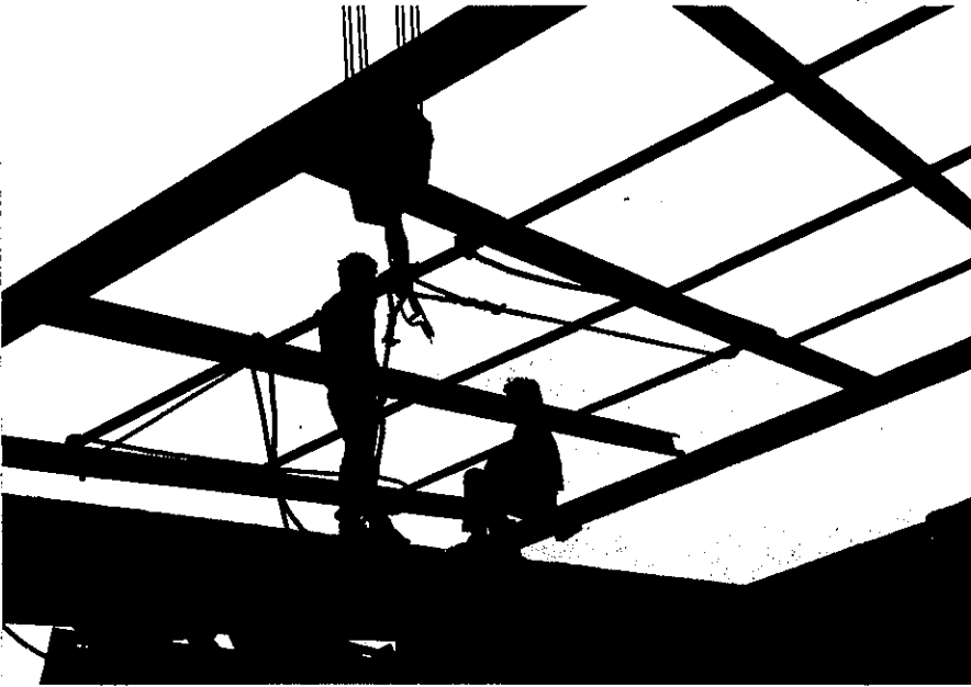
屋根鉄骨組立工
