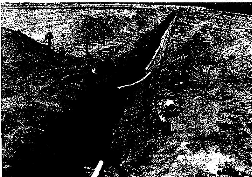
3"放流管据え付け工
