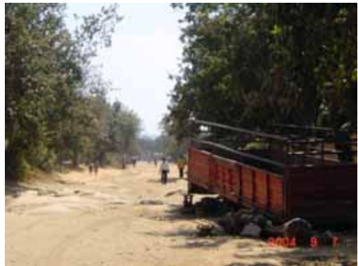
写真-10 追加要請された区間の現状
