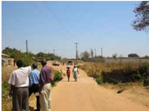
写真-7 カルバート幅員が不足している
