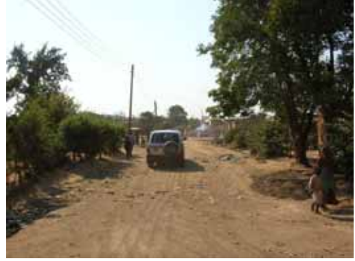
写真-2 コンパウンド内は路盤が未整備で排水施設が破損している。
