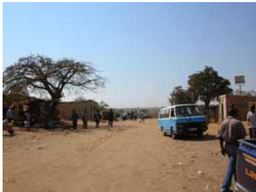
写真-9 現況バスターミナル付近の舗装状況
