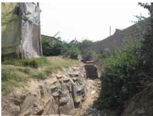
写真-5 PHC(Primary Health Care)により整備した側溝
