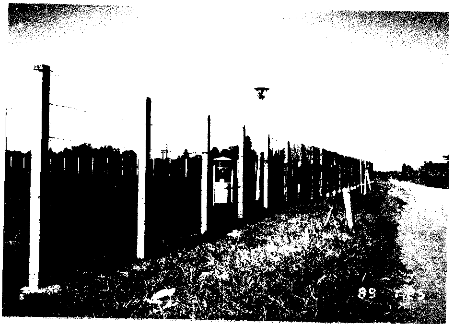
№ 9 防風ネット工完成
