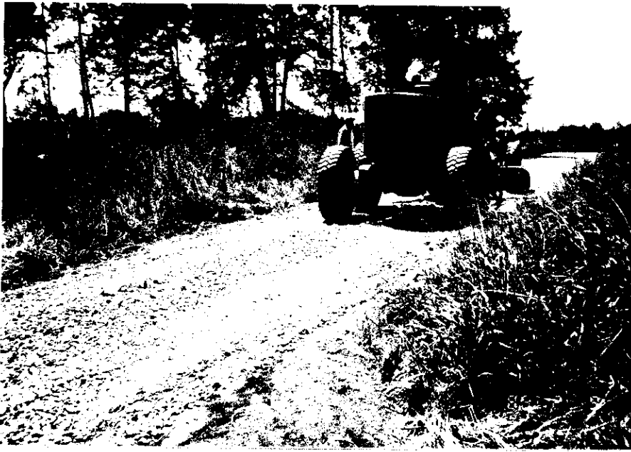
№ 5 農道整備工 砂利舗装 敷均し状況
