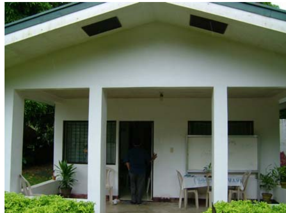
ビコール地域、マスバテ州 村落保健所
