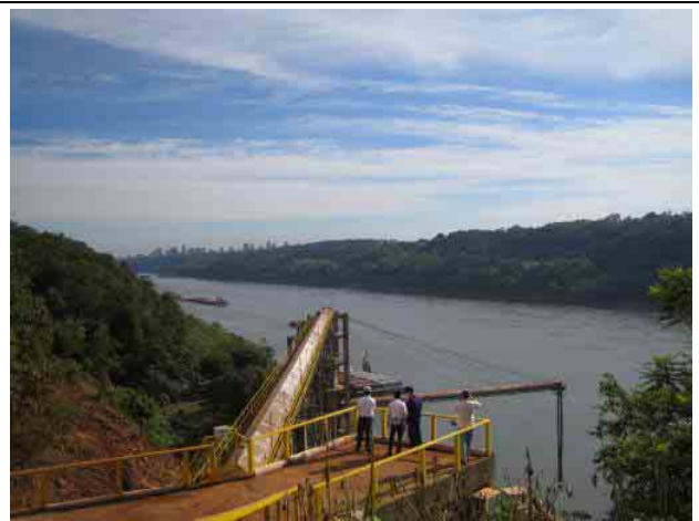
写真 6-2 No.1 Tres Fronteras 港 (民間建設管理港) (対岸の高層ビルはブラジルの Foz Doyguacu、右側にはイグアス川が見えアルゼンチンとなる。3国が対峙する場所という意味)
