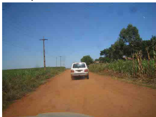
農地を通過する接続道路
