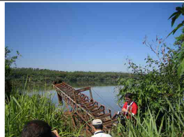
写真 7-4 No.7 Caarendy 港 (ピラボ農協所有・MOPCへ移管中) (シューターと水面までの高低差おほとんどない)
