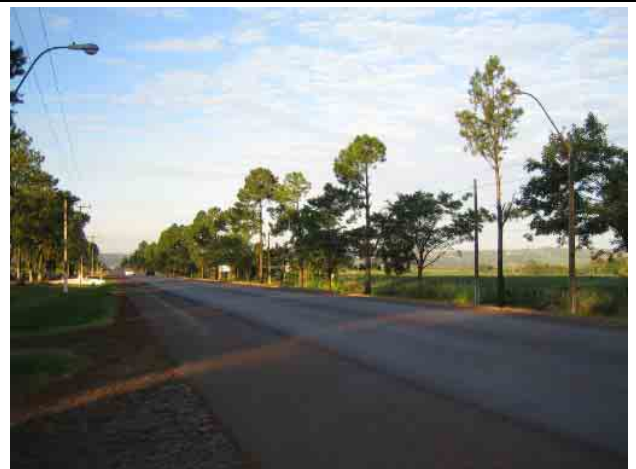
写真5-2 接続する国道6号 (接続する国道6号は、円借敷により舗装されている)
