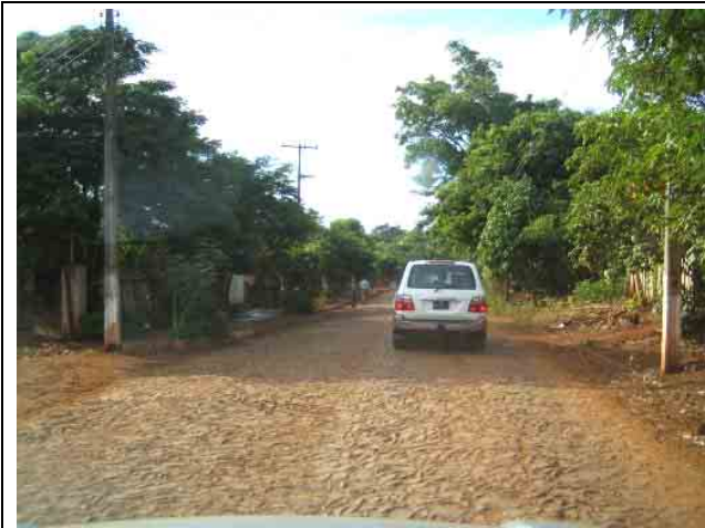
写真 6-1 No.1 Tres Fronteras 港までの接続道路 (住居地域を通過する道路。拡幅する場合は、住民との調整が必要。)
