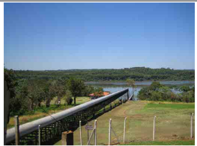
写真 6-12 No.6 Don Joaquin 港 (民間建設管理港) (シューターの長さは200m)
