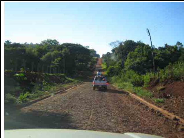
写真 6-13 No.8 Parcdon 港までの接続道路 (疎林、二次林、一部住居区域を通過する。国道 6 号から数キロは石畳舗装となっている)
