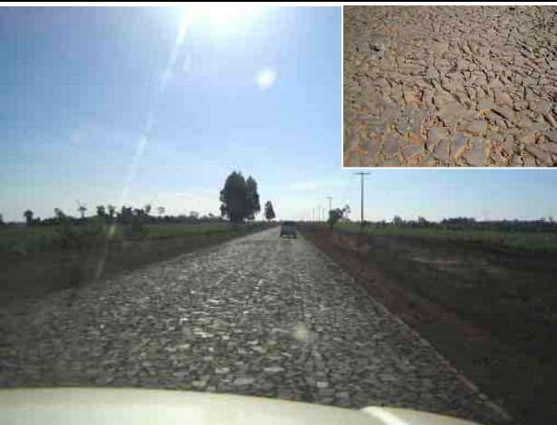
写真5-1 回廊3~7km区間の状況 (工場以西から国道6号まではMOPCにより石畳舗装がされている)
