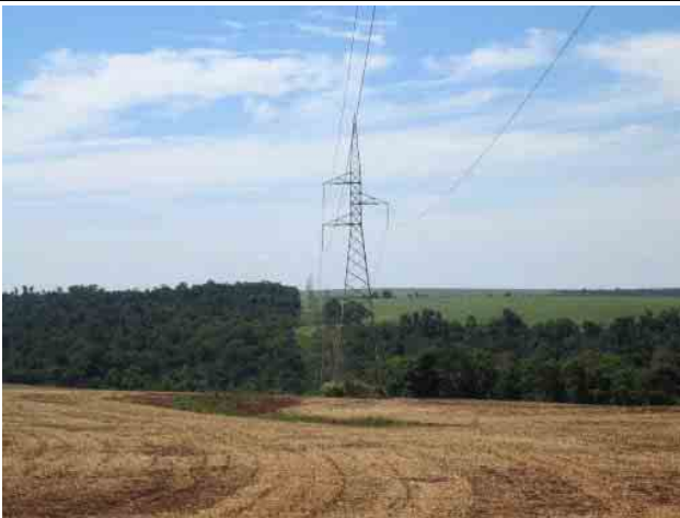
写真 1-11 送電線下部に道路のない区間
