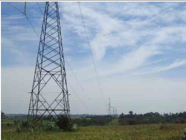
写真 1-5 回廊3-7km区間の状況
