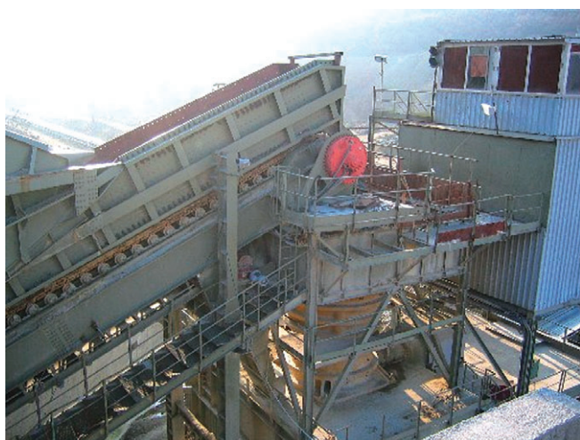
Krivelj 露天掘り鉱山ずり破碎機
