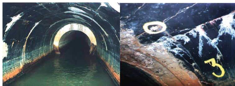
図4-6 廃滓堆積場ダム2内部の排水トンネル
