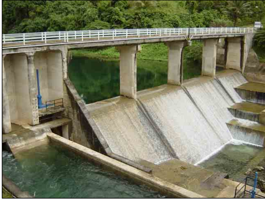
サラカタ水力発電所 取水堰 越流状況
