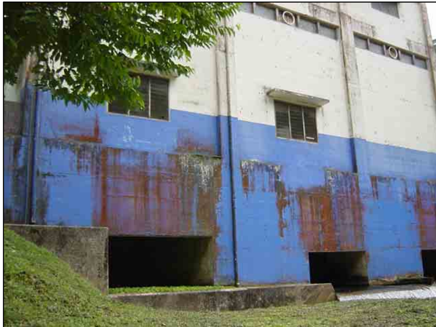
サラカタ水力発電所 放水口 右から1・2・3号機用ピット
