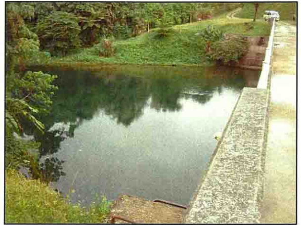
サラカタ水力発電所 取水堰前面 池の水草・流木清掃直後
