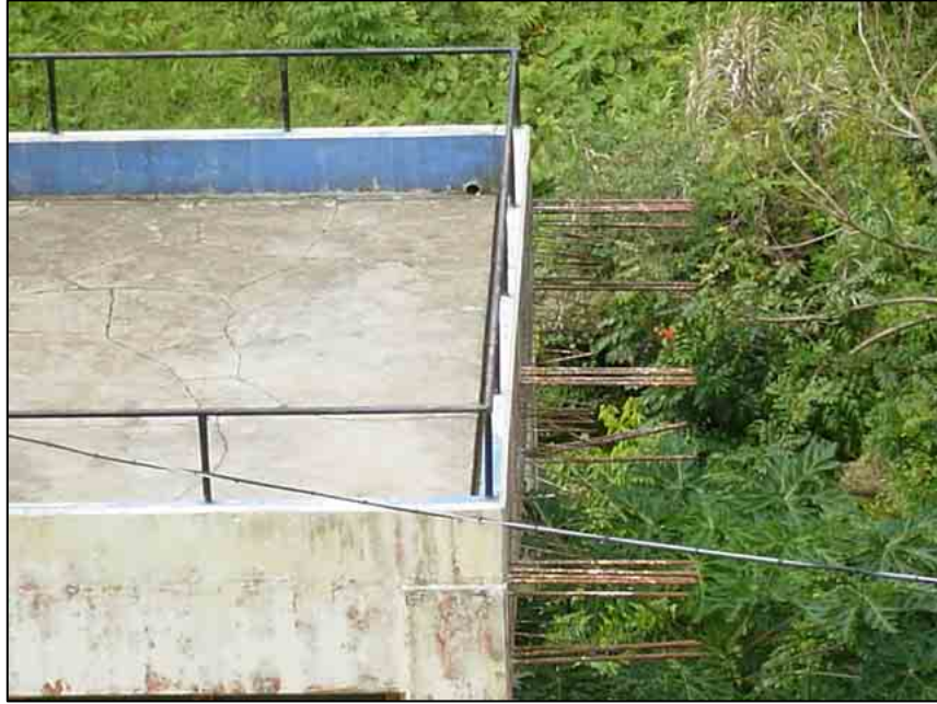
サラカタ水力発電所 本館 増設用梁鉄筋張り出し状況
