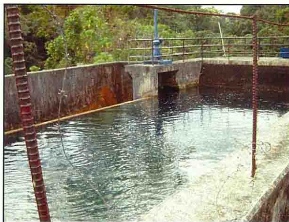
サラカタ水力発電所 取水路 斜面侵食による土粒子堆積状況
