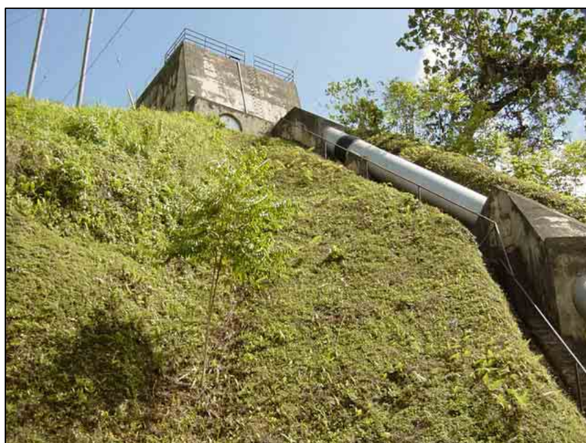
サラカタ水力発電所 水圧鉄管路 3号機用整地状況
