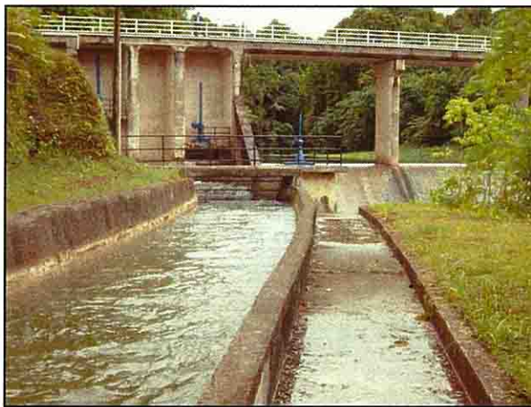
サラカタ水力発電所 取水路 余水吐側溝
