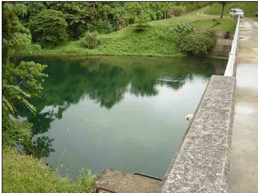
サラカタ水力発電所 取水堰前面 池の水草・流木清掃直後
