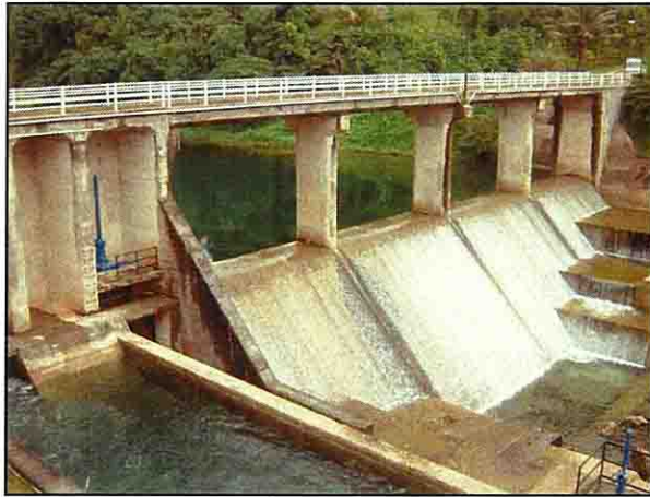
サラカタ水力発電所 取水堰 越流状況
