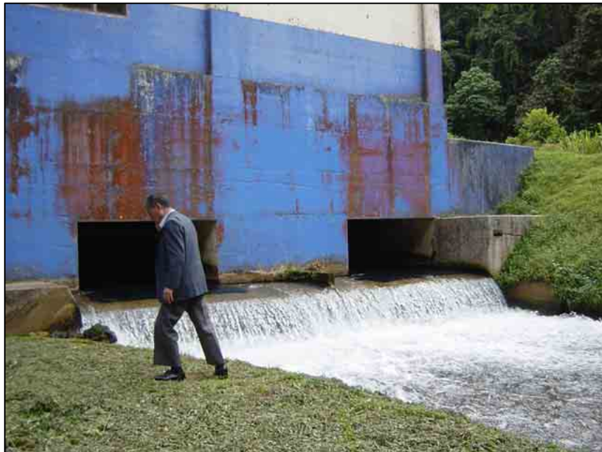
放水口 右から1・2号機用 3号増設は放水路(手前)建設が必要
