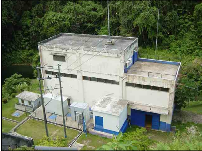
サラカタ水力発電所 本館建屋
