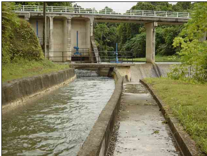
サラカタ水力発電所 取水路 余水吐側溝
