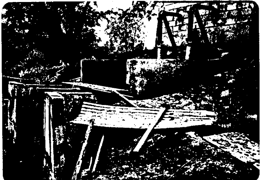
吸水槽壁嵩上げ (1 m)
