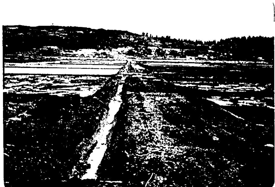
第3 農道及び第3 用水路 仕上げがほぼ終了し農道砂利敷きを待っている
