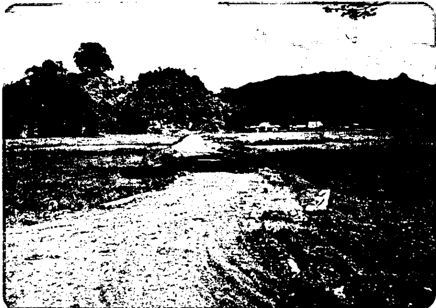
第3農道及び第3耕区 仕上げ及び砂利敷き状況
