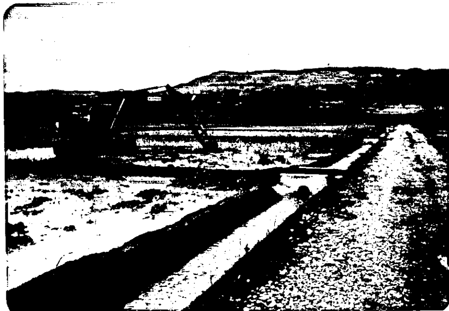
ディガーによる最終均平作業状況
