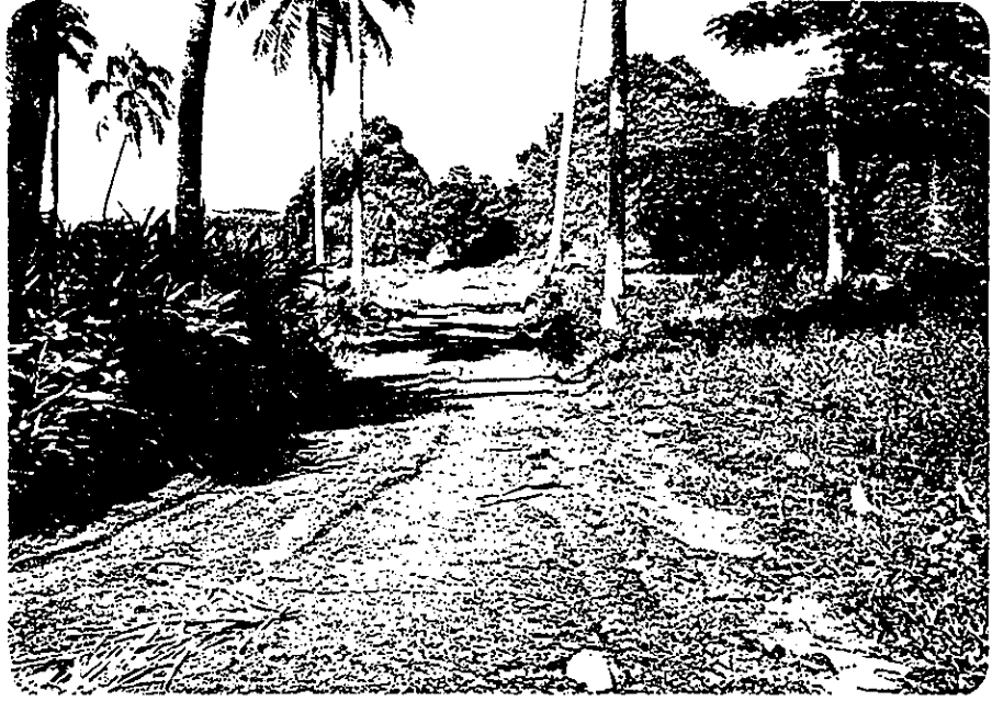
第2-2農道 仕上がり状況
