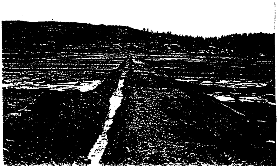
第3 農道及び第3 用水路 仕上げがほぼ終了し農道砂利敷きを待っている
