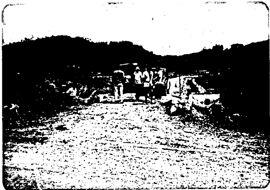
第2-1農道及び第2耕区 仕上げ及び砂利敷き状況
