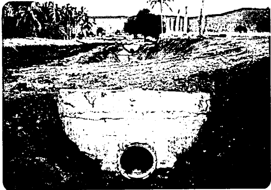
第6農道 排水暗渠修復中
