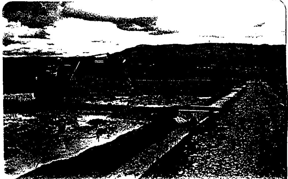
ディガーによる最終均平作業状況
