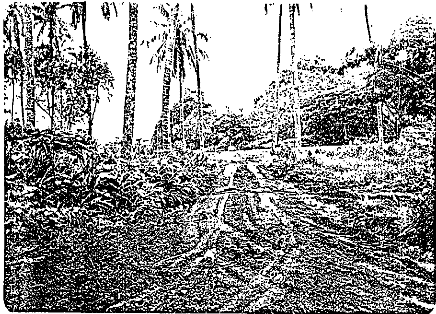
第5農道 農道砂利敷き前状況
