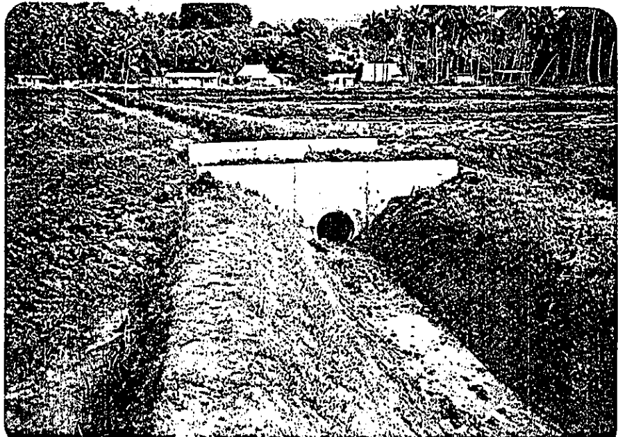
排水暗渠 完了後、農道盛り土状況。
