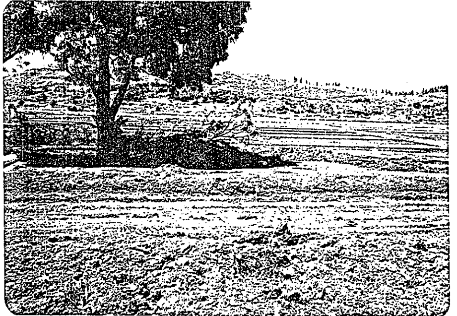
第3 耕区 最終仕上げ後、地盤沈下がおこり手直し余盛り工事が進められている
