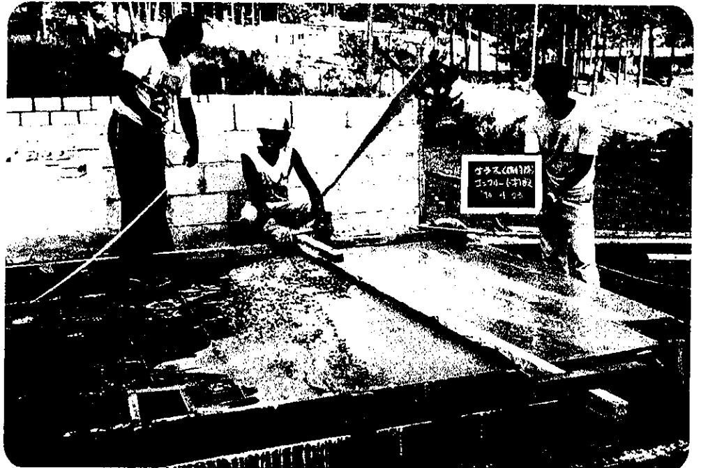
テラスコンクリート打設状況
