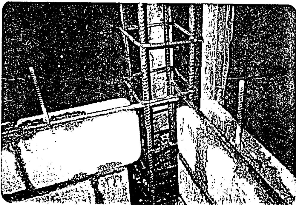
ブロック 水平鉄筋設置状況
