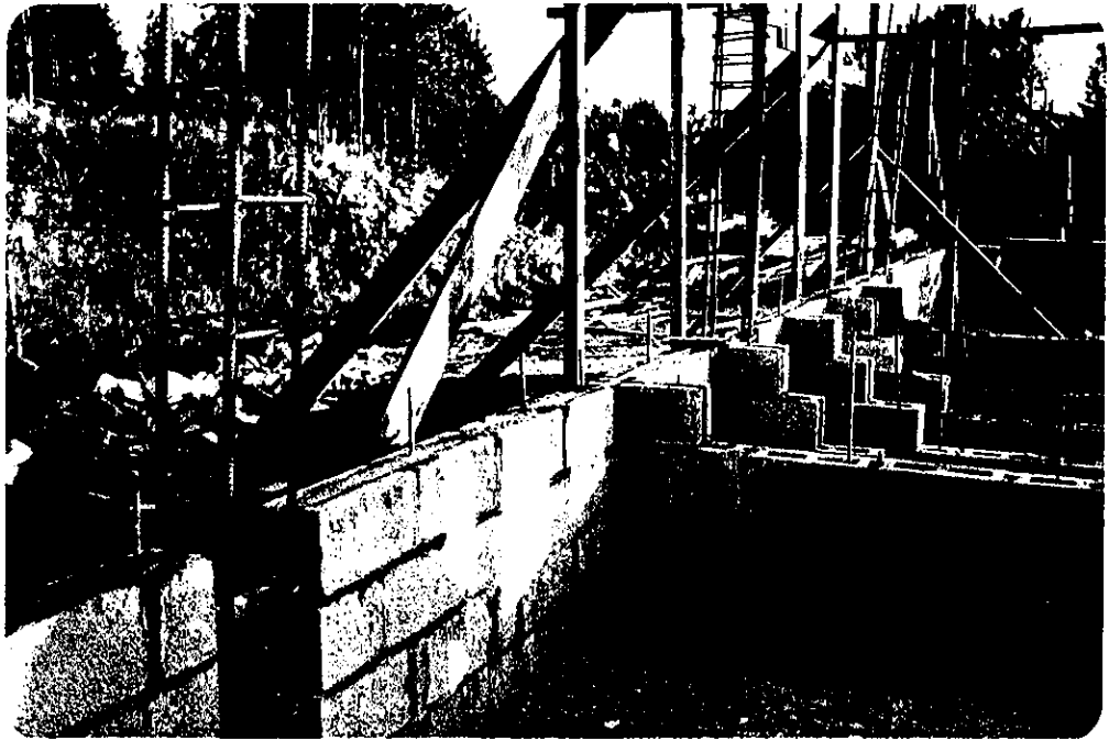
ブロック積工事
