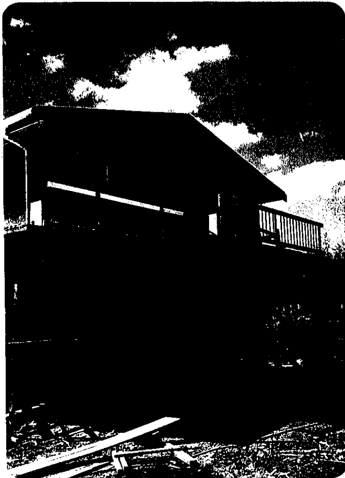
回廊手摺り設置工事
