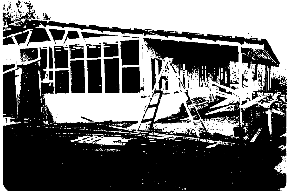
外壁用化粧板設置状況
