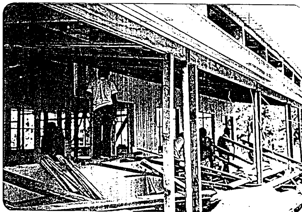
外壁（木構造部）工事
