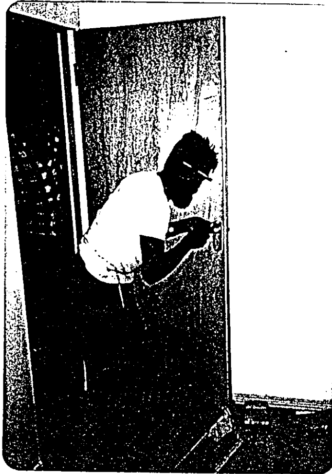
内部ドア設置状況
