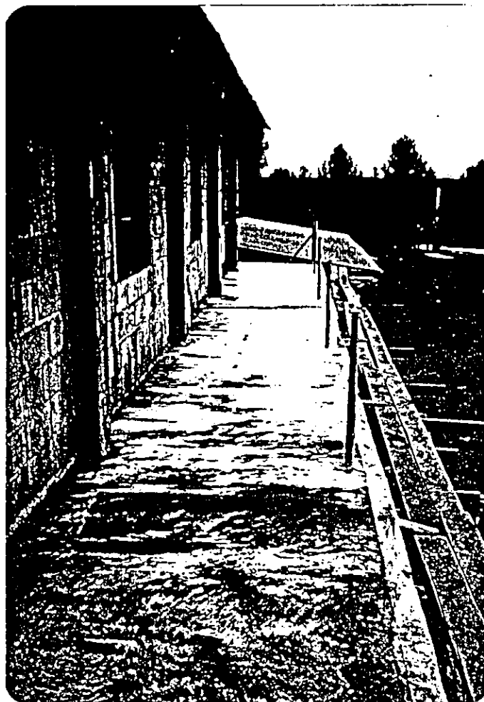
バルコニースラブ完成状況
