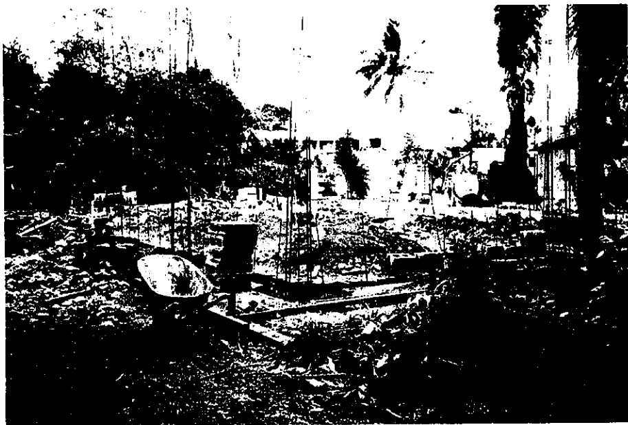
基礎工事 (フーチング、柱工事)
