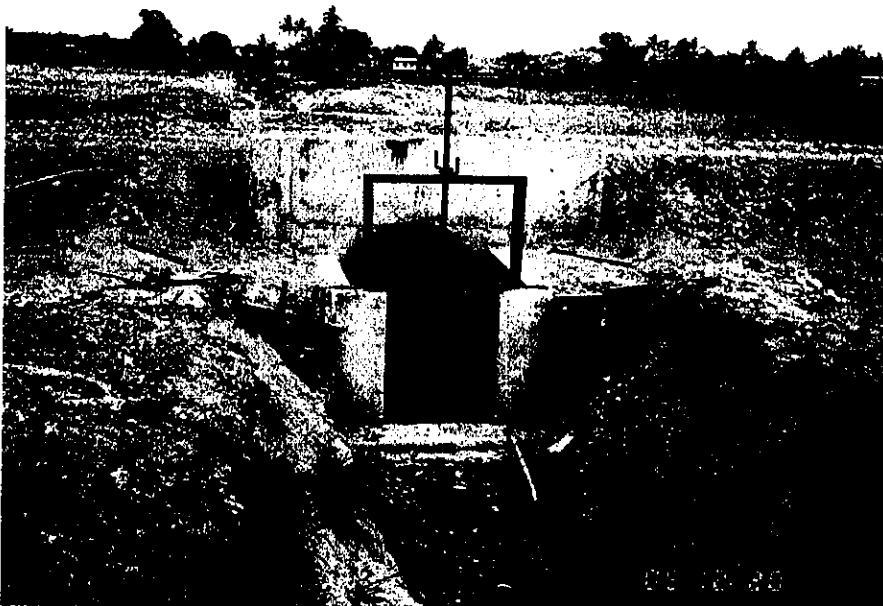
チェックゲート工事 (B-1/No.1地点)
