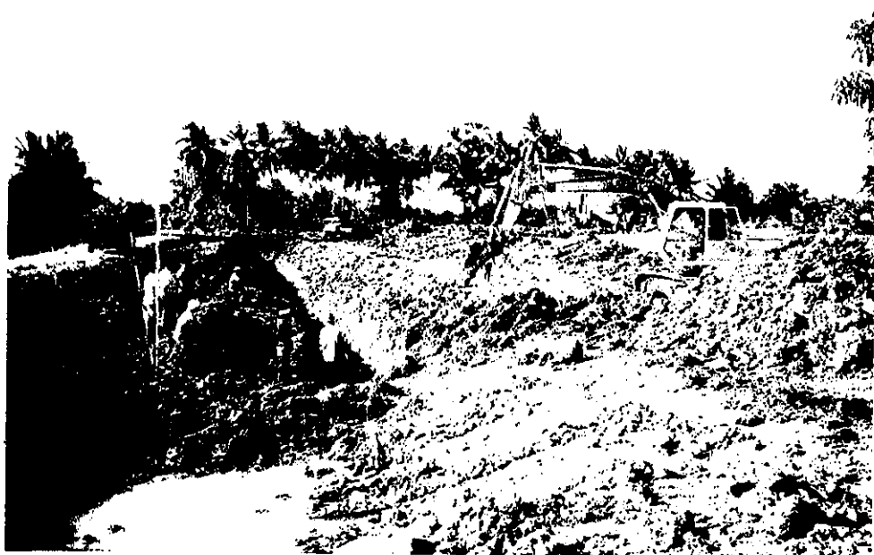
水路敷掘削後 のり面形成開始
