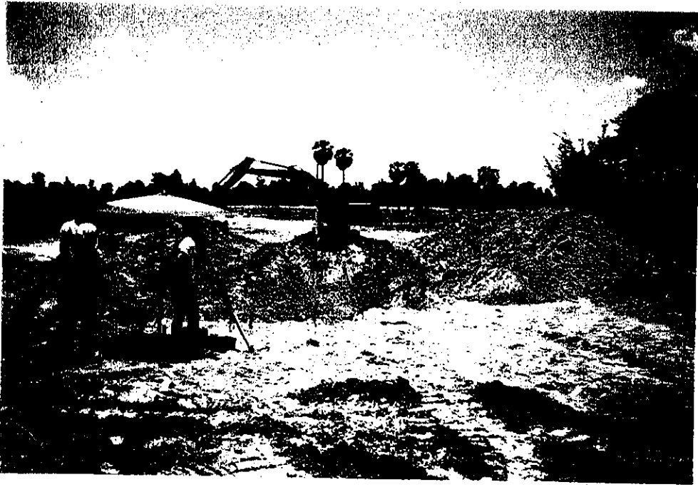
ハクトンチャイ水路掘削開始
