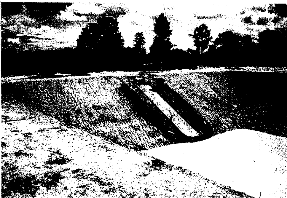
P-4 スローププロテクション 施工中
