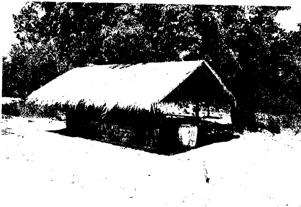
P-15 豚舍建設完了
