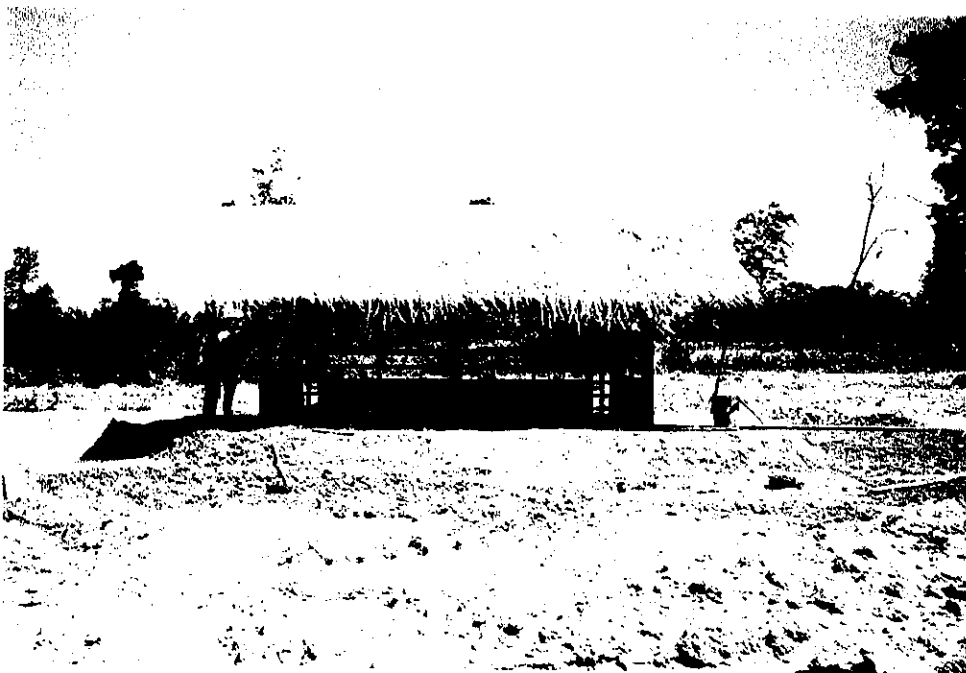
P-17 豚舎建設完了
