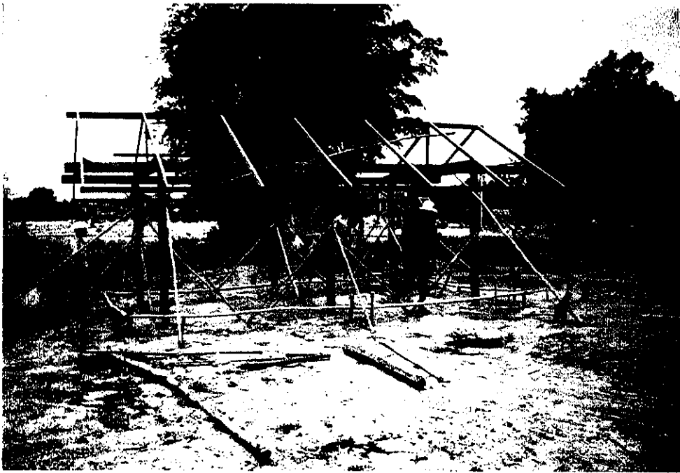
P-5 豚舎建設中
