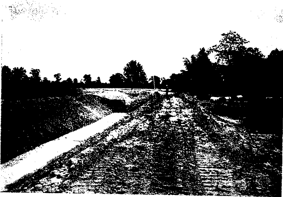
中間点施工中
