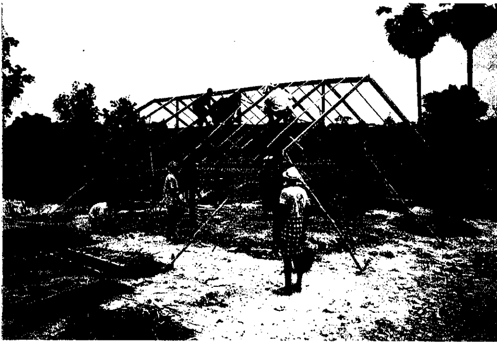
P-1 豚舎建設状況
