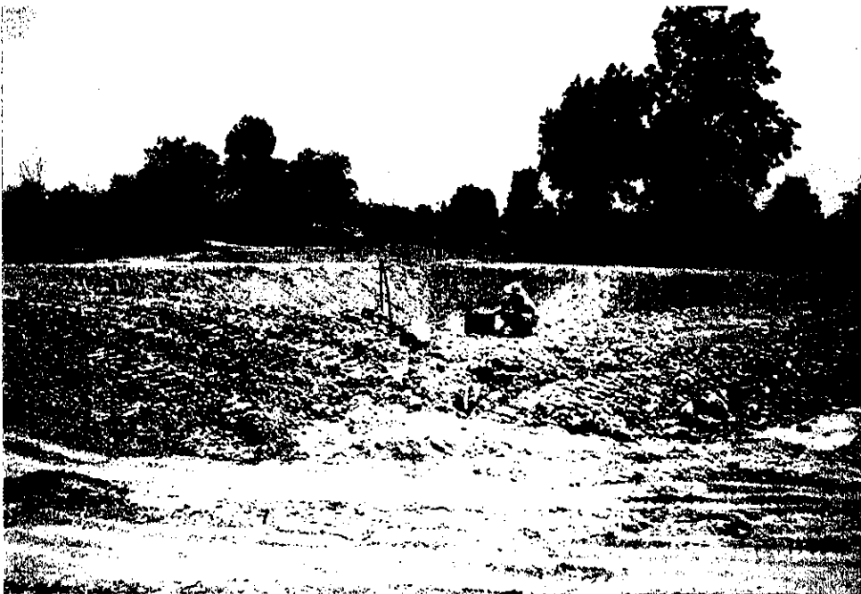
P-6 のり面形成 盛土敷均し
