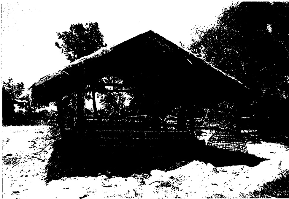
P-13 豚舎建設完了
