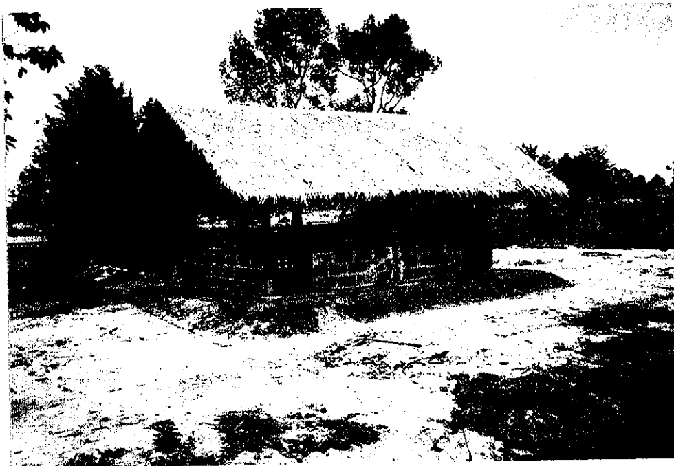
P-9 豚舎建設完了
