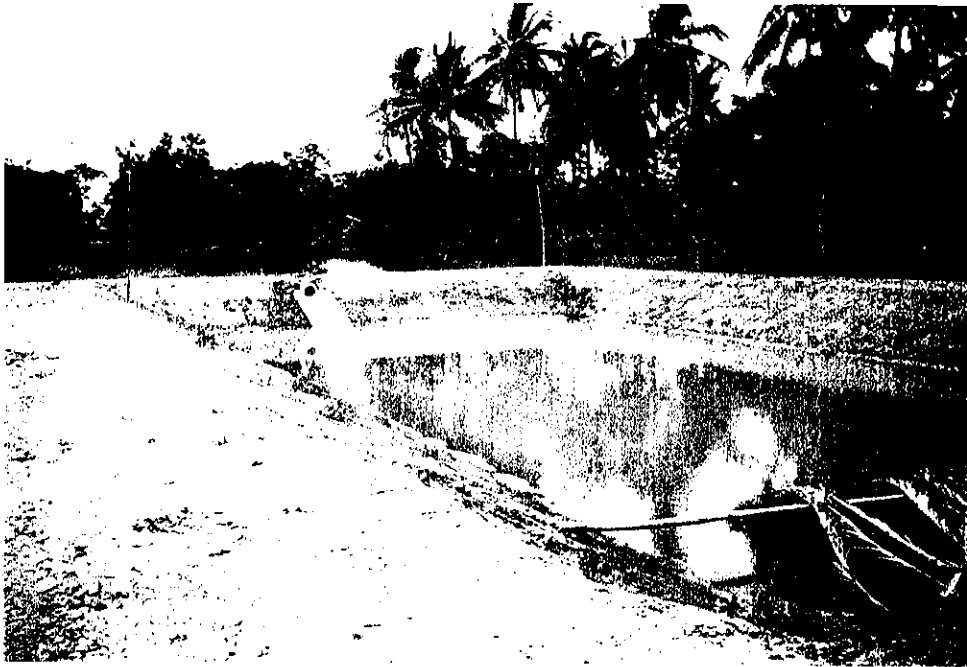
P-1 施工後湛水状態
