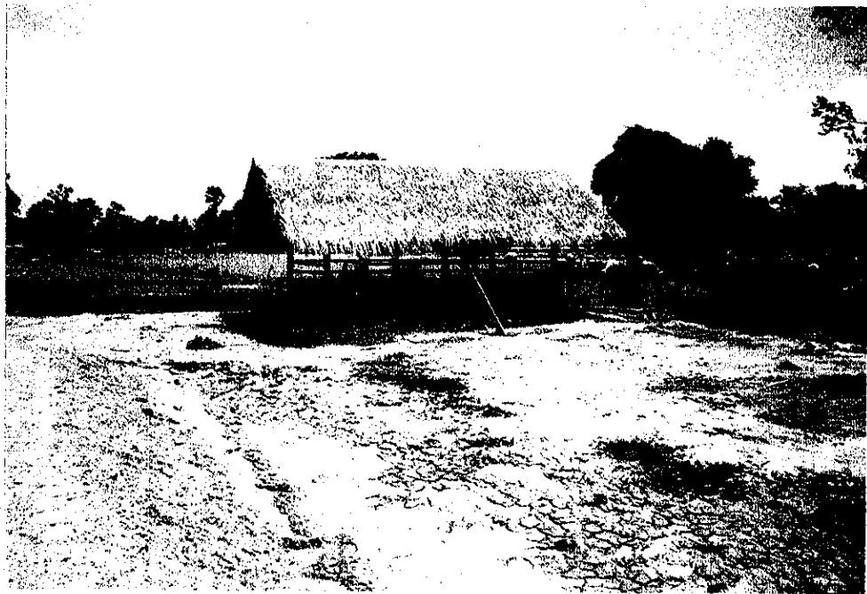
P-6 豚舎建設完了
