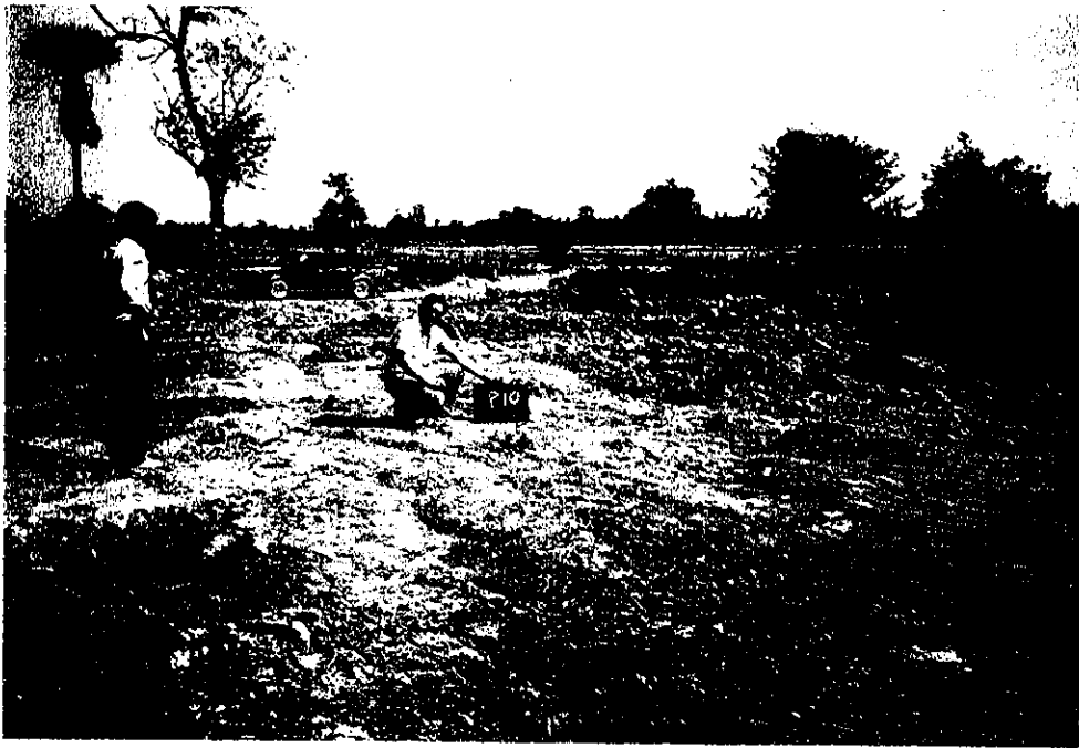
P-10 施工開始前
