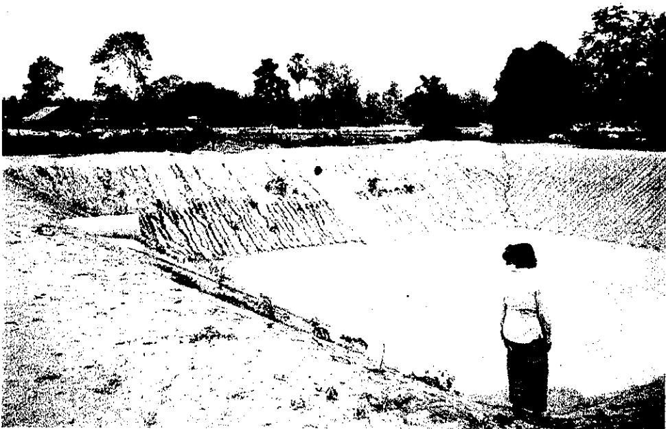
P-7 施工後湛水状態
