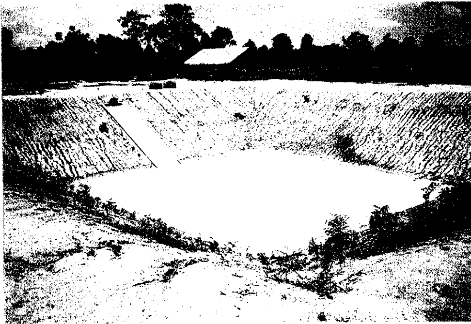
P-8 施工後湛水状態 豚舎建設中
