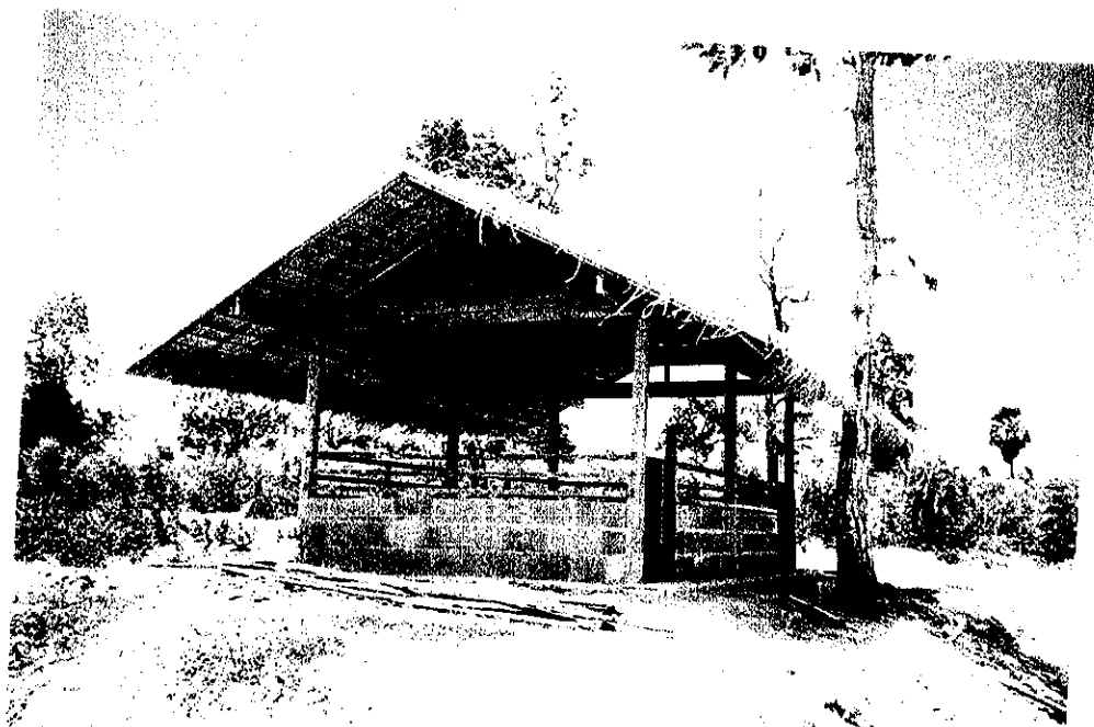
P-12 豚舎建設完了
