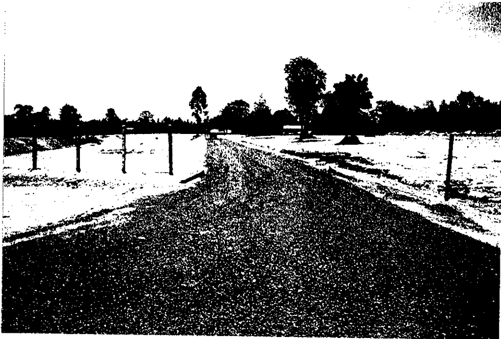
追加工事砂利舗装
