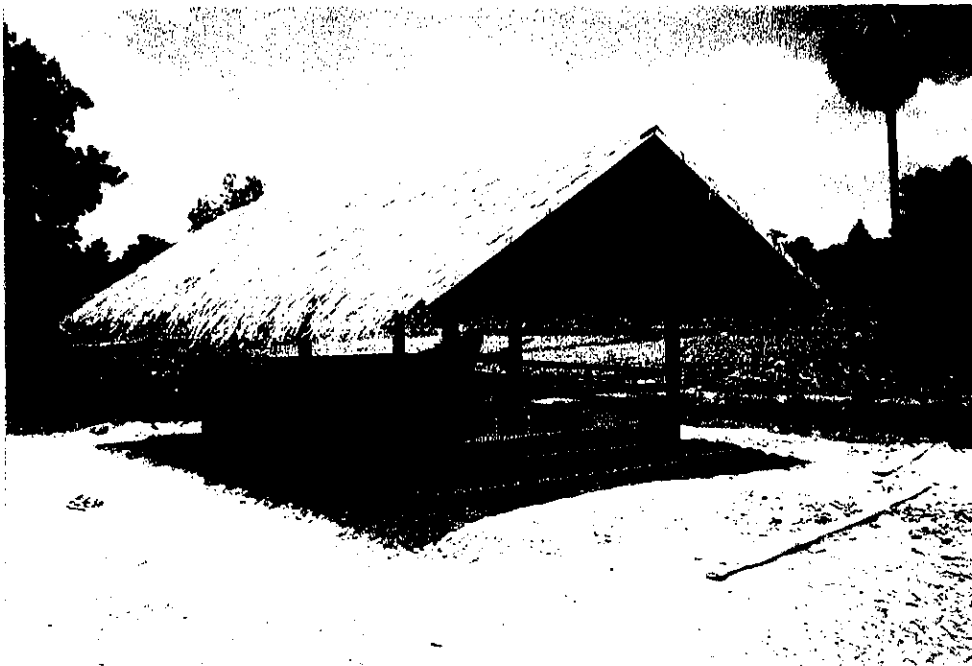
P-1 豚舎建設完了
