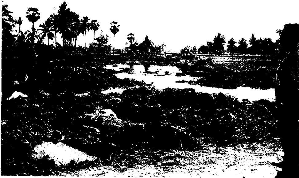
掘削開始前 敷均し状態
