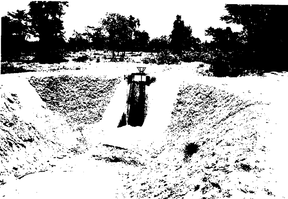
末端ゲート部分施工後
