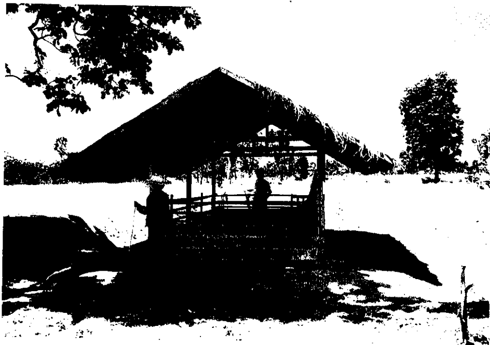
P-16 豚舍建設完了
