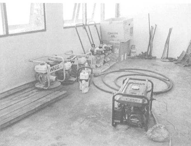
10Kva の小型発電機
