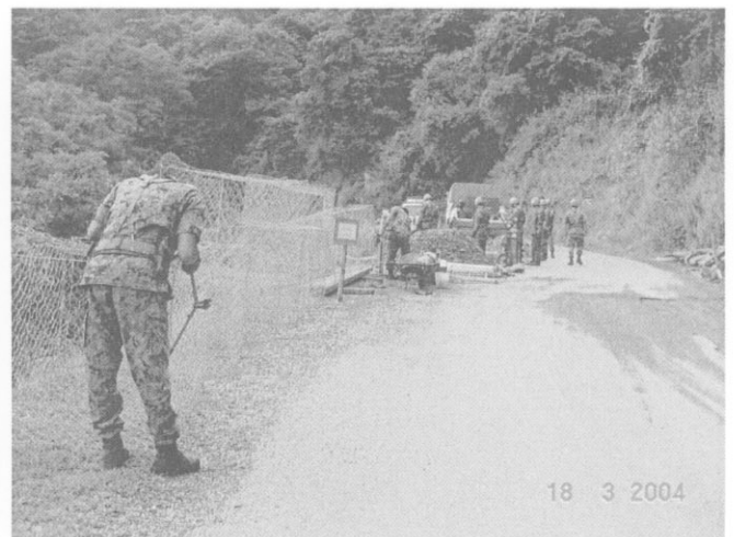
修復工事中の JEG 施設部隊
