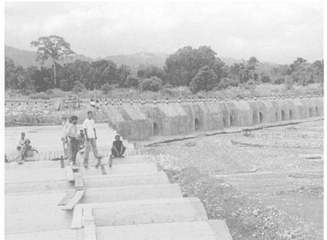
工事中のカルバート部分
