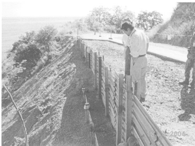
JEG により修理中の道路
