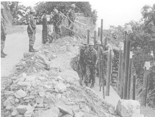
修復工事中の JEG 施設部隊
