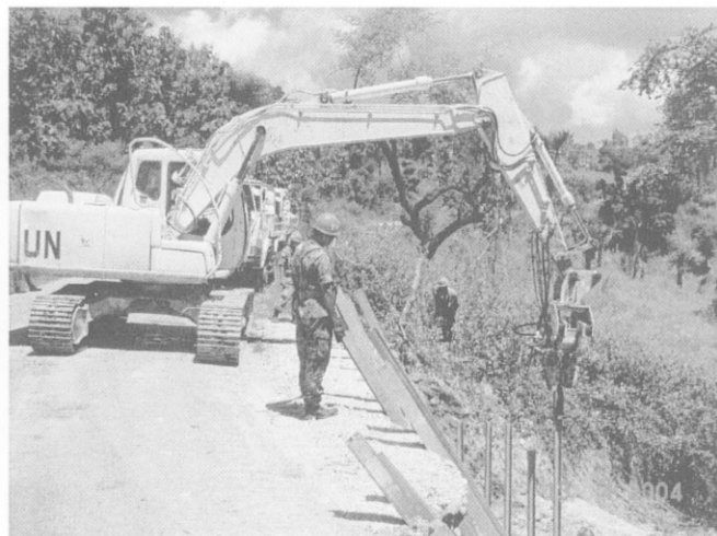
道路工事中の JEG 施設部隊
