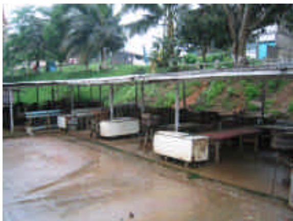
サイト東側に位置する既設食堂
