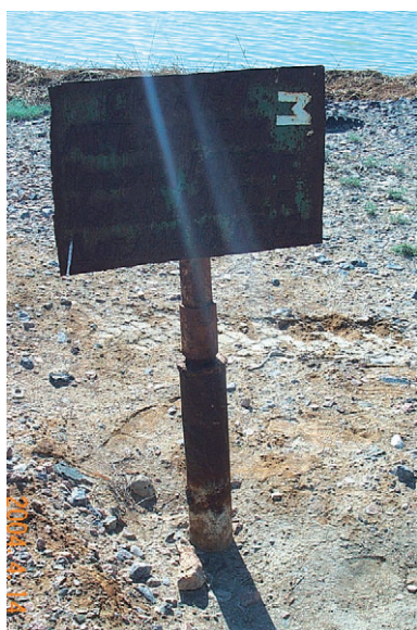
写真3 ア．の方法により閉止された油井
