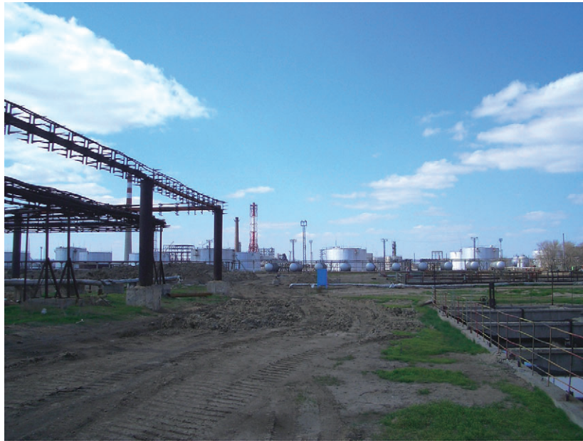
改修工事が進むアティラウ製油所
