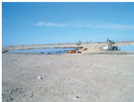
堤防内のトレン・ウゼク油田（左側はオイルスラッジ溜） 右側には塩が析出しているところが見える （カスピ海の塩分は普通の海の4分の1程度である）
