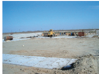
建設中のピット (5,000m 3 )
