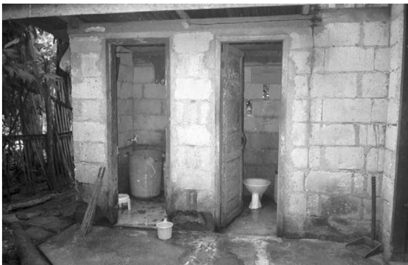
写真 14 母屋と併設されているト イレ
