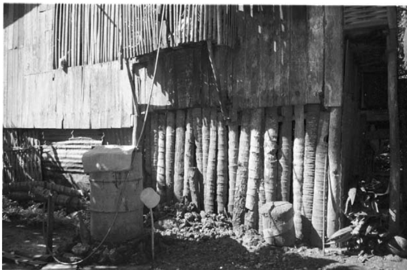
写真 06 流しの水も流し台の竹の すきまからそのまま流さ れる。 (写真 05 を外側から見た ところ)
