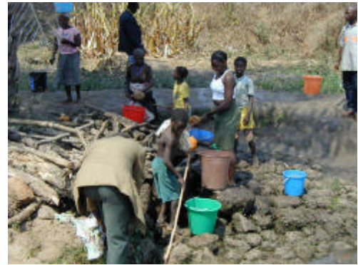
写真 3-5 セレスの村落給水(手掘り井戸)
