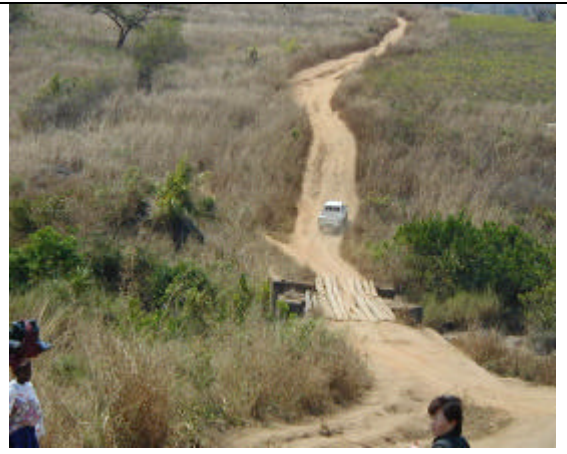
写真-28 道路と橋の状況(セレス-コンダ間)
