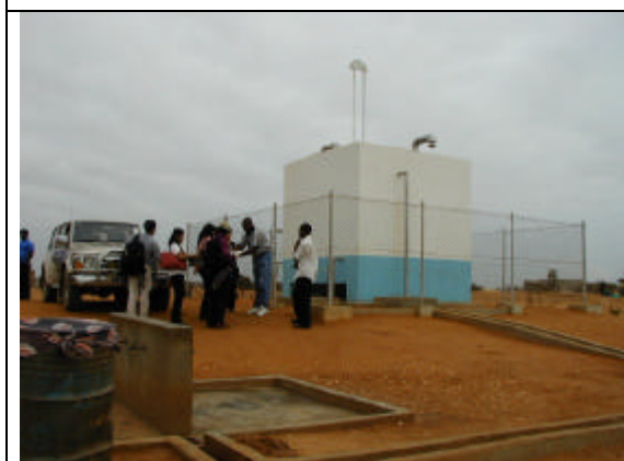
写真-17 Chendovava 給水施設、給水車に より貯水槽に水が運ばれる。
