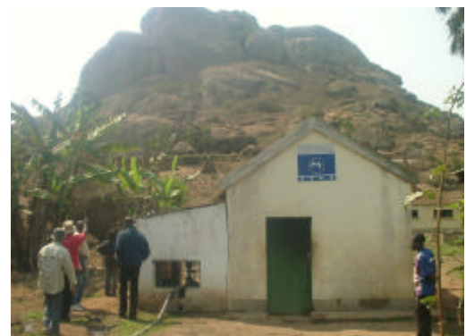
写真 3-4 セレス市街の給水施設
