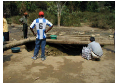
写真 3-3 カナカッサラ地区の給水施設 (手掘り井戸)
