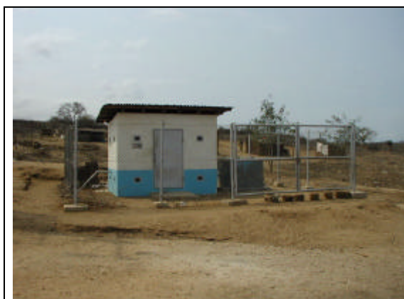
写真-13 KM45 村給水施設、 井戸ポンプ室。
