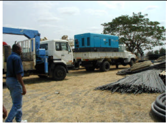
写真-20 同左、エアコンプレッサー・クレーン車。
