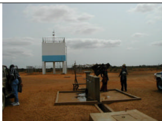
写真-14 Bita Tangué 給水施設、 手前は共同水栓、後方は貯水槽。
