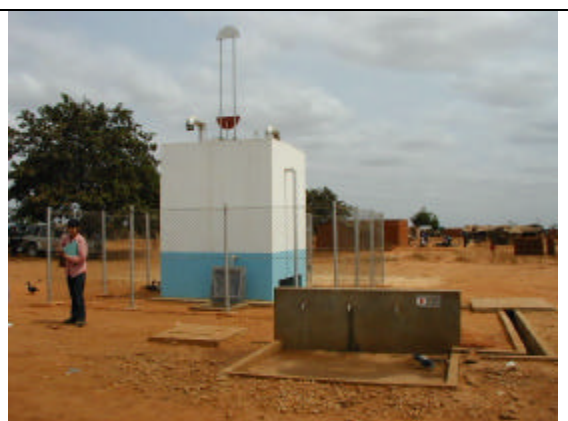
写真-18 KM-30 給水施設、左と同様に 給水車により水が運ばれる。
