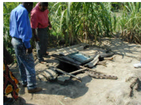
写真 3-6 コンダの村落給水(手掘り井戸)
