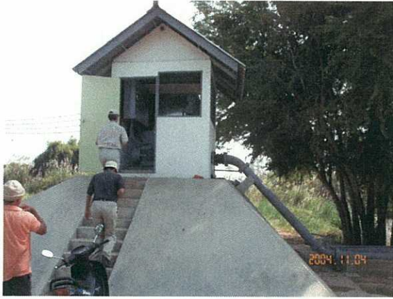
BTPW 事業地区における 新設ポンプ場
