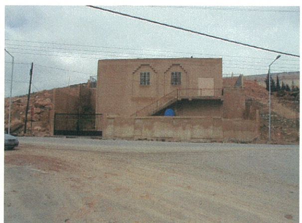
ヤブース導水管路線 最終接続地点である既存タケア減圧槽
