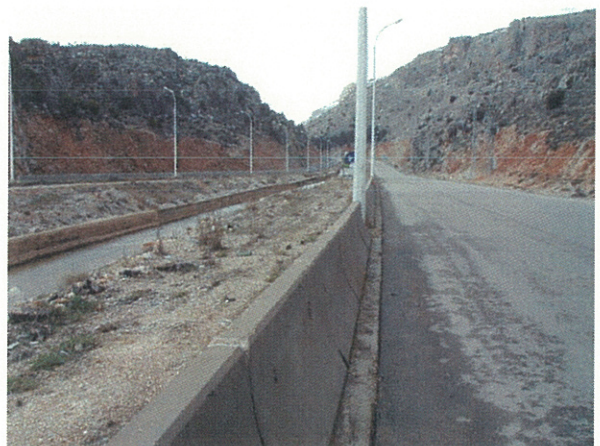
ヤブース導水管路線、中央に河川があり 導水管は写真右側の路肩に布設される
