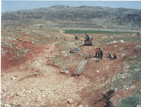
ヤブース水源地の全景 手前に井戸 No.1、遠方に導水管を 敷設する高速道路が見える
