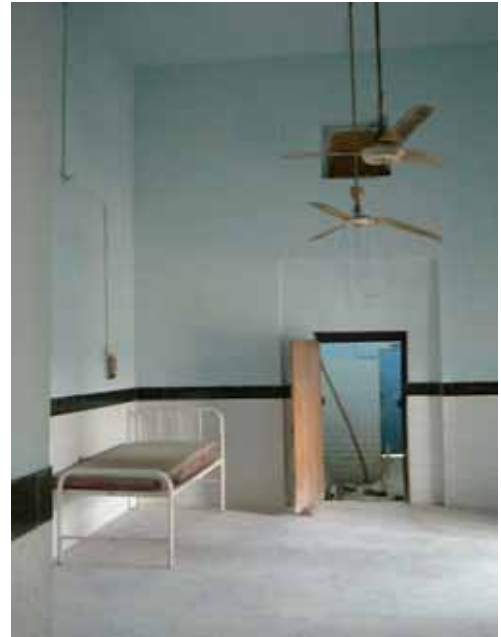
旧内科病棟: 改修工事中の病室。
