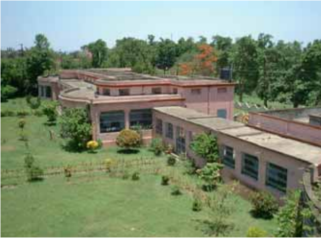
外科病棟外観(南側)
