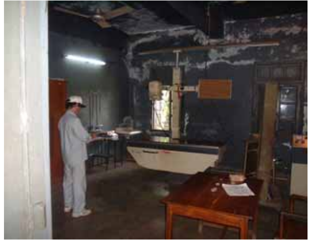
外来棟放射線撮影室： 窓から放射線がもれて防御が不完全である。
