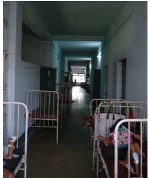
感染症病棟病室： 病室不足で廊下にベッドを置いて患者を入院させている。
