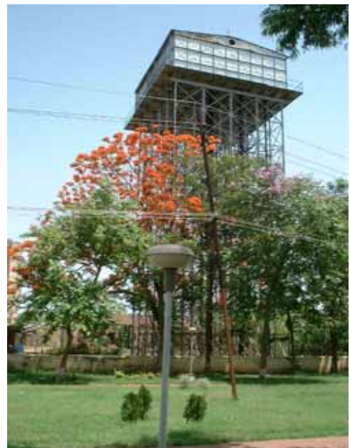
断水時に利用される地域用高架水槽
