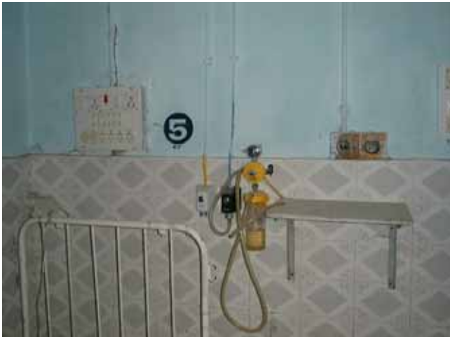
旧内科病棟: 改修工事中のICU
