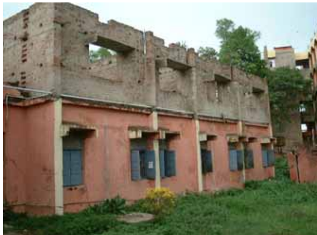
新内科病棟外観(東側) 2階増築の工事は中断したままになっている。
