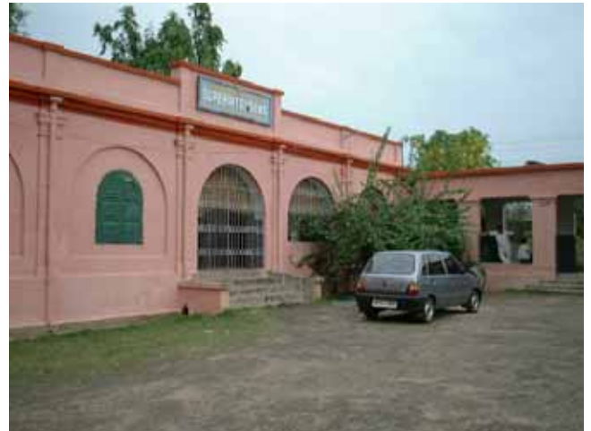
管理棟外観北側:
