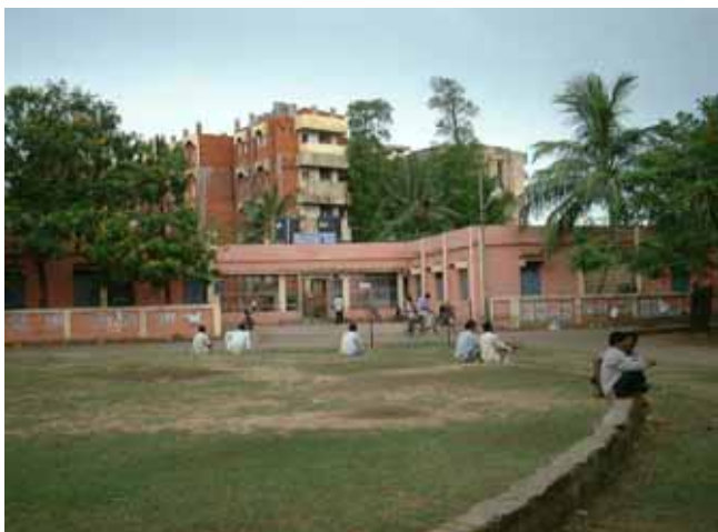
新内科病棟外観(北側) 新内科病棟の南側に高等裁判所が位置している。
