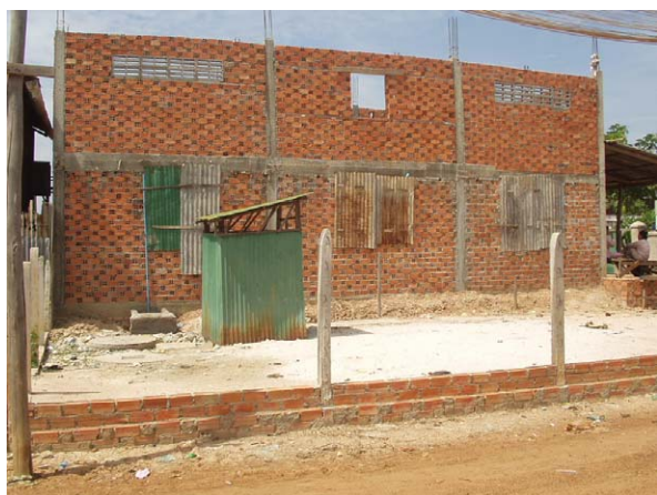
戸別に設置されたトイレ
