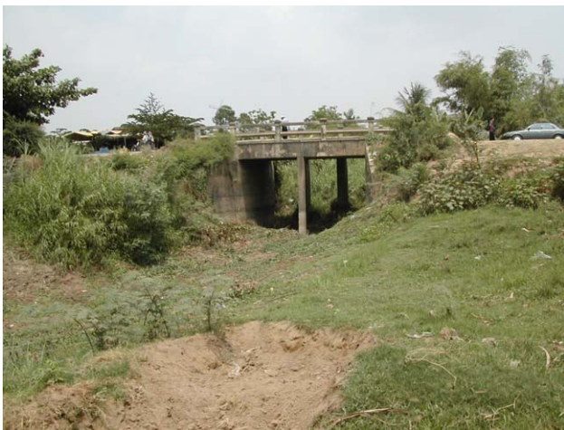
水門 BC-11 STA.49+995付近
