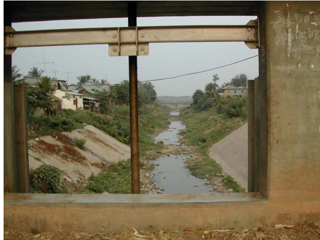
水路の整備状況 STA.28+432
