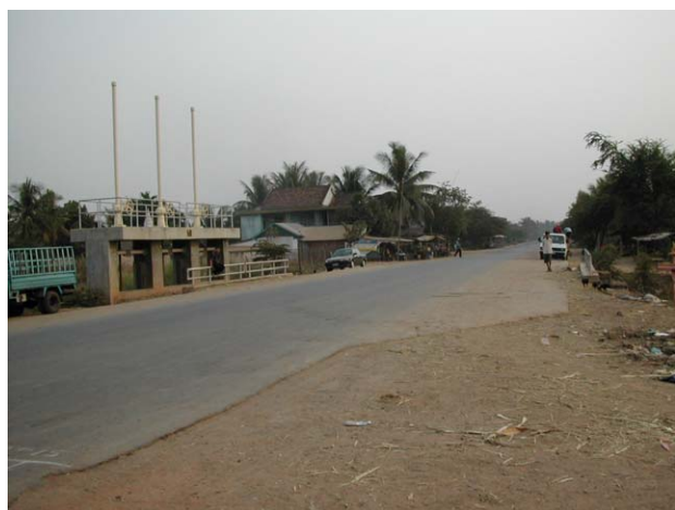
水門 WG-1 STA.28+432付近
