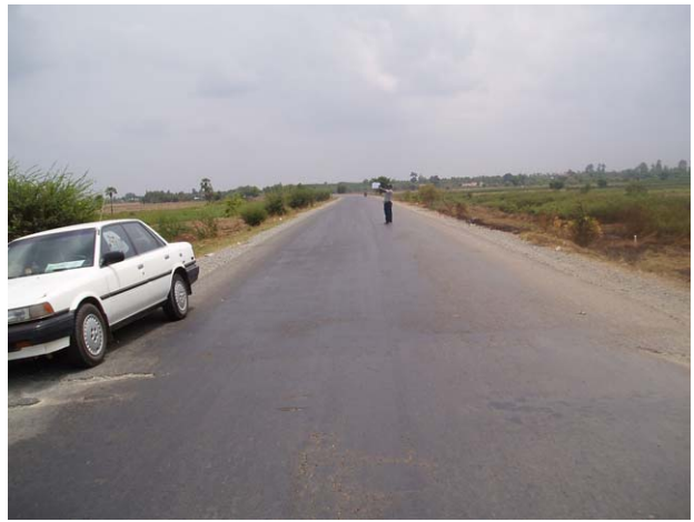
道路現況 STA.42+190付近
