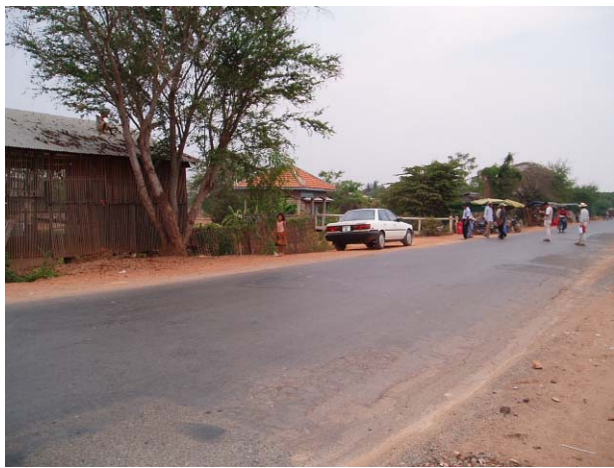
道路現況 STA.25+360付近
