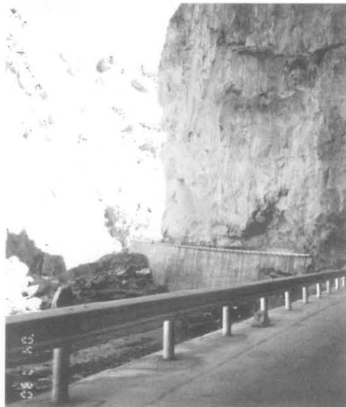
落盤の危険がある観光地への主要道路
