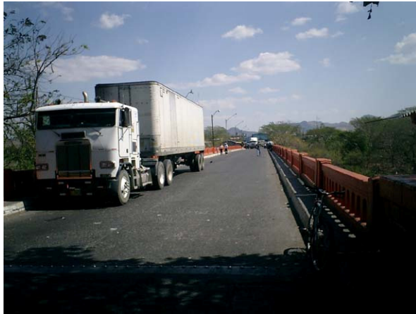
アマティージョ道路橋
