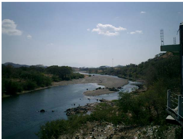
アマティージョ道路橋架け替え候補地
