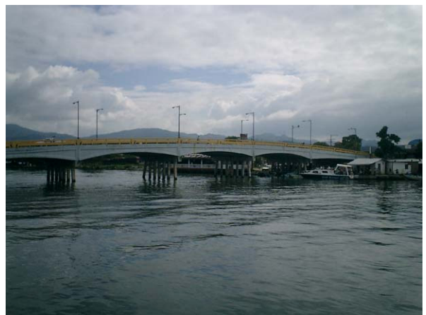
市内へのアクセス道路 (道路橋部)
