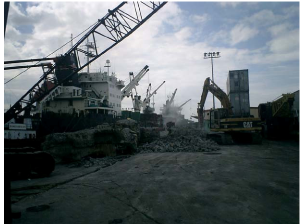
6 番埠頭改良工事
