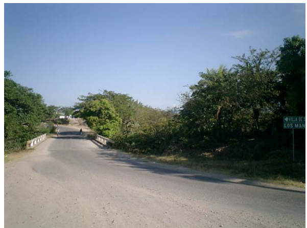
コマヤグア～アマティージョ間未舗装道路 (橋梁部)
