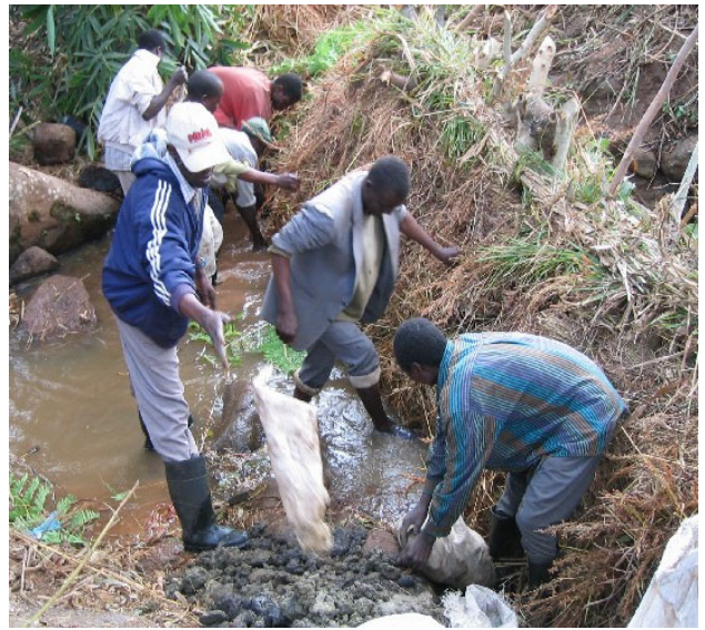
幅約 4m の小河川に建設中の堰
