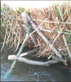
背後を支える三角支柱
