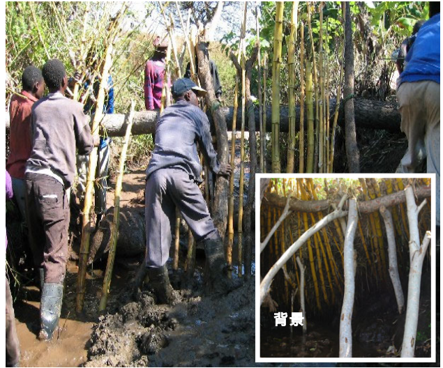
幅約 4m の小河川に建設中の堰
