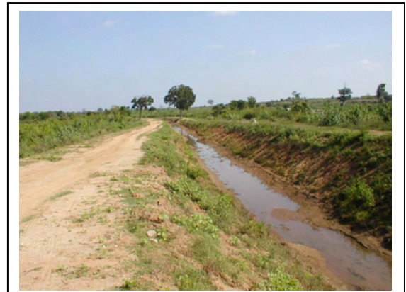
マウアラ転流事業で建設された水路 (水路の設計流量は 4.32t/sec)
