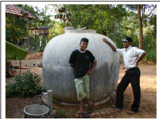
農家に設置された貯水タンク (容量は 5,500L)
