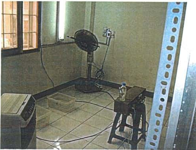
写真 9 : 空調装置 (温湿度調整)
