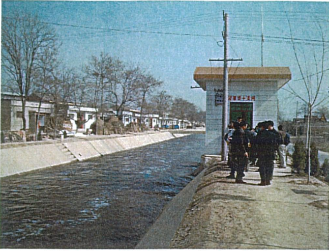
幹線水路 支線水路への取水口付近
