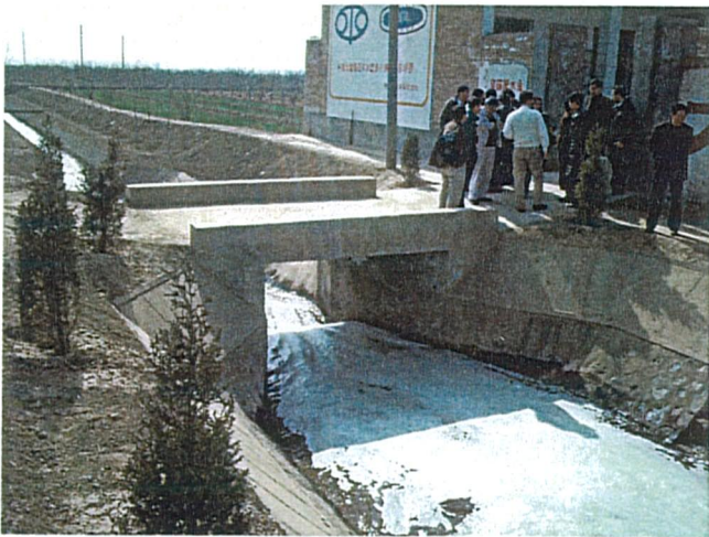
支線水路流量観測点、後ろの建物は配水所
