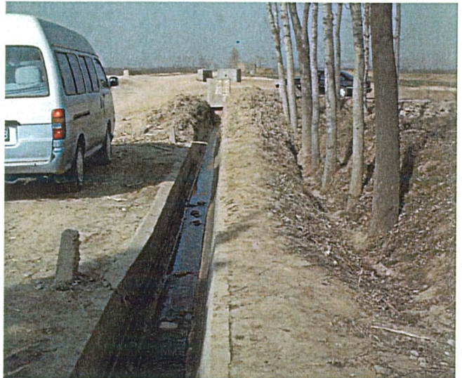
三次水路上流部
