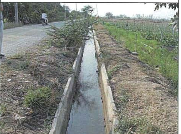
写真-12: タイ MWMS プロジェクトサイト④
