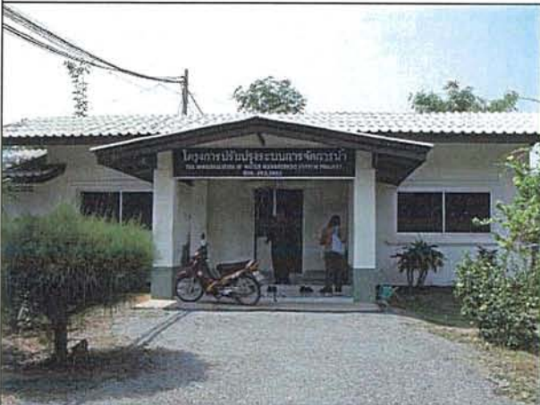
写真-9: タイ MWMS プロジェクトサイト①
