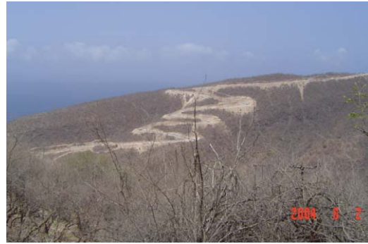
道路建設による地形の変更（6月：乾季）
