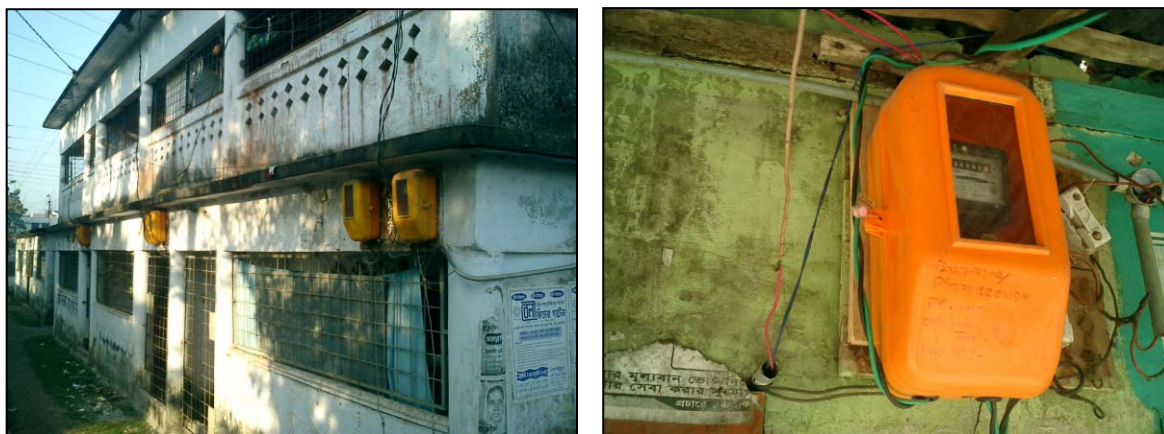
写真 4-3-2 計器設置状況
