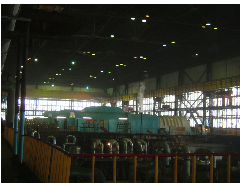
(アクモリンスカヤ熱電併給所／カザフスタン) 老朽化したタービンやジェネレーター
