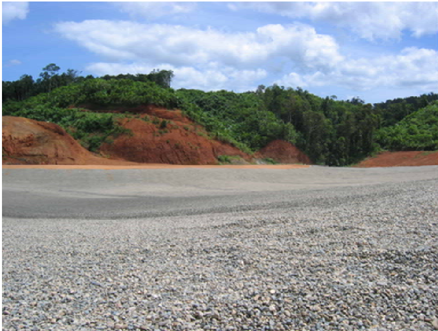
写真3：EUの援助によって建設されたナンボロ廃棄物処分場（フィジー）
