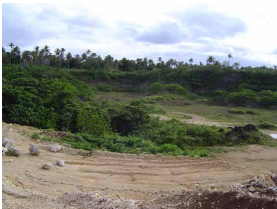
写真 2：AusAID の援助によって建設中の新廃棄物処分場（トンガ、トンガタブ島）
