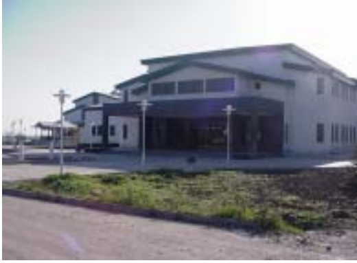
研修センターの外観（正面から）
