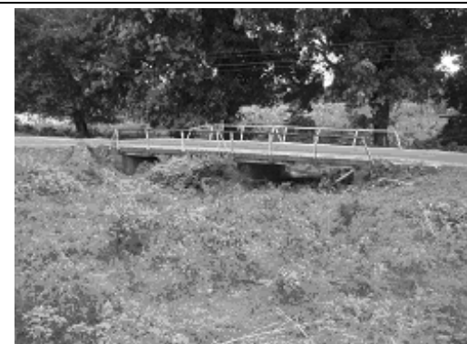
洪水時の道路部避溢橋（右岸）
