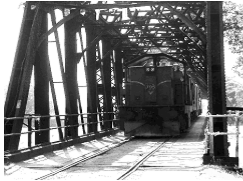
列車通過（軌道面は道路床版に改修されている）
