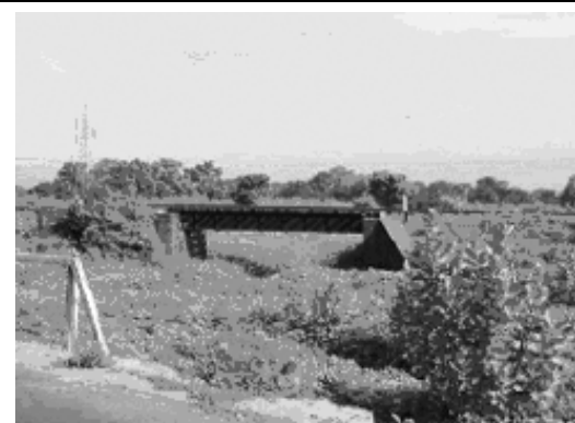
洪水時の鉄道部避溢橋（右岸）
