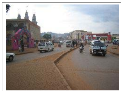
一方通行化工事の完成後(ショッピング付近)
