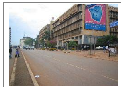
右折れ禁止化工事の完成後(市内中心部)
