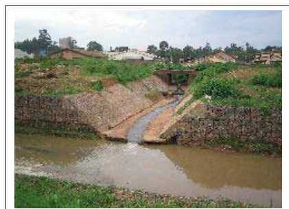
改善後のナキボ排水路(第6街路付近)
