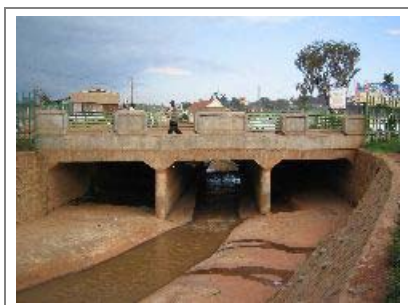
改善後のナキボ排水路(クロックタワー付近)
