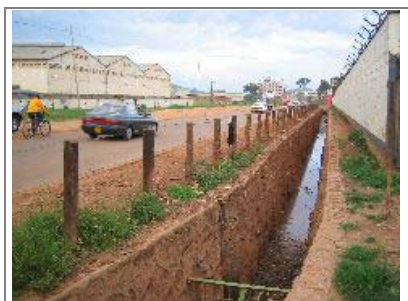
改善後のナキボ支線(第8街路付近)
