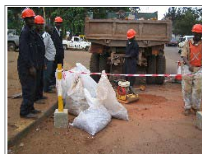
試掘・路床材サンプリング状況
