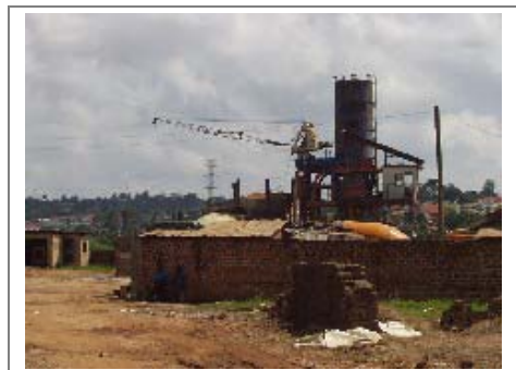
コンクリートプラント(エピック)
