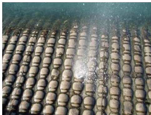
③ 削孔部からの海水の噴出
