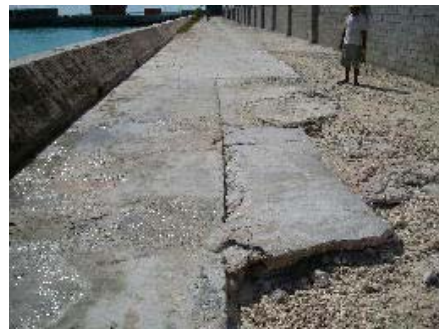
④ 道路の補修 (No.1~3 付近)
