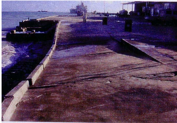
写真 2-5 護岸道路の被災状況（2002 年）
