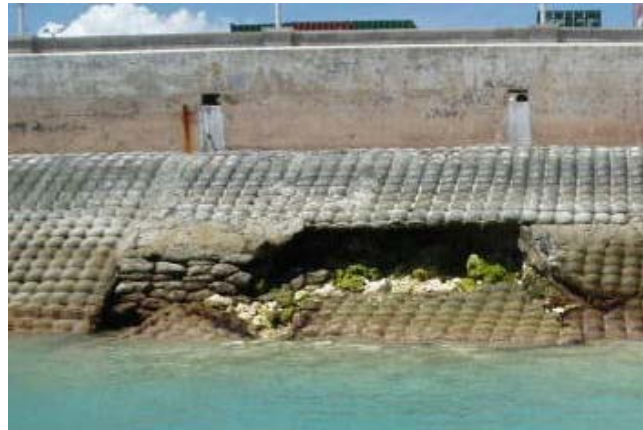
写真 2-1 ファブリマット護岸部の被災状況
