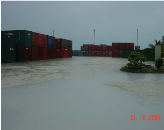
(無償資金協力実績-1) ベシオ港コンテナヤード
