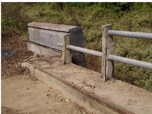
タビスⅡ橋 高欄損傷状況
