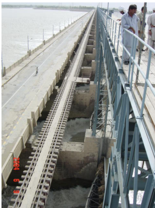
タウンサ堰に併設する道路、鉄道
