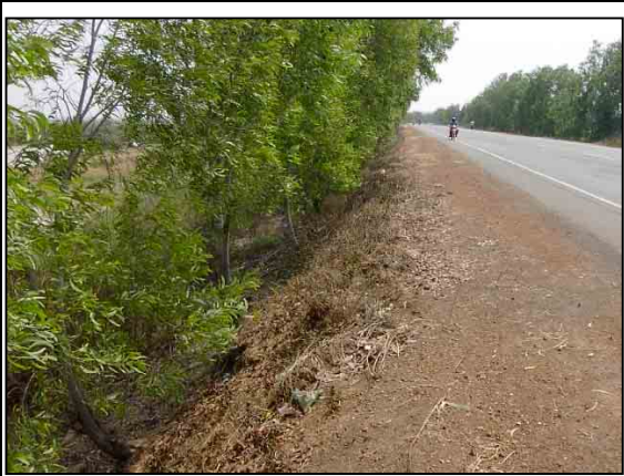
RN6 Br.2取り付け部斜面。ユーカリより崩壊は免れているが、斜面の大部分は洗い流されている。
