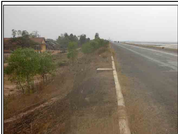
RN51 右写真の反対側斜面。植生による斜面保護工を設置。
