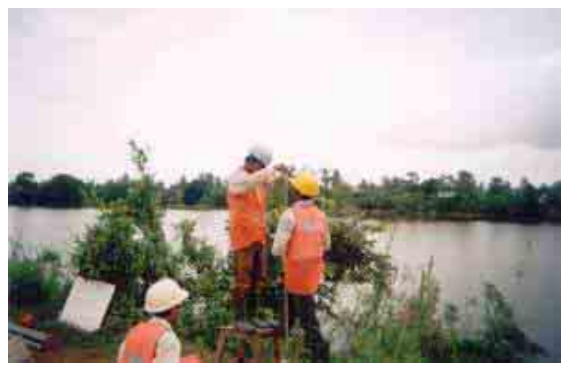
A6A-3 (Sta. 35km+610) 雨季現場状況、洪水位が路面から約2m下まで上昇している。
