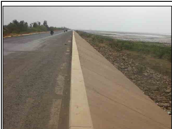
RN51 ADBにより工事された路線。メコン川の影響を受ける斜面に大規模なコンクリート護岸を設置。
