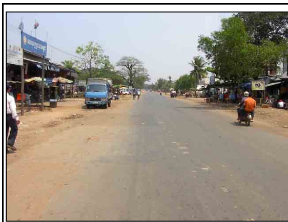
RN6 集落PHAAO。排水施設、バイクレーンが破壊されている。
