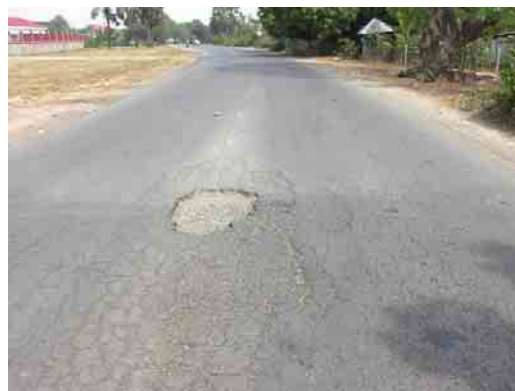
写真 2.1.1 亀甲クラックと剥離
