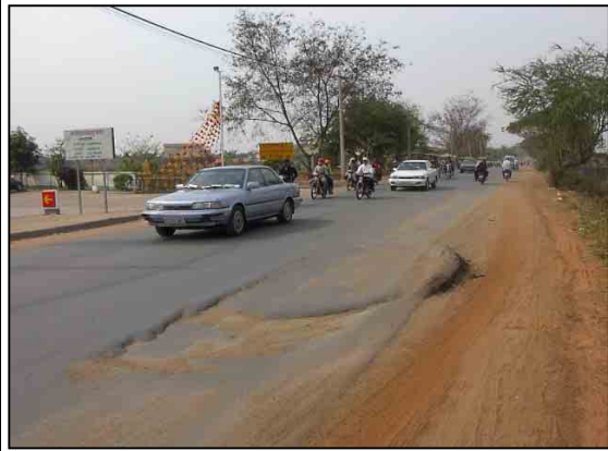
RN6A 1km地点のガソリンスタンド前の舗装流動。給油トレーラーによるもの。
