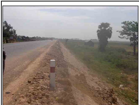
RN1 ADBにより工事された路線。メコン川の影響を受ける斜面に石張り護岸を設置。
