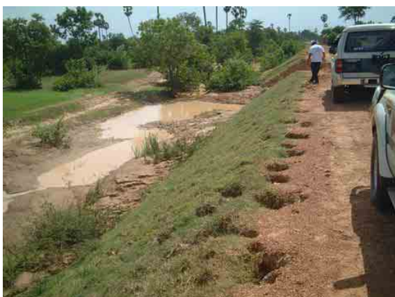
写真 2-5-4 雨季のドラゴンホール (調査範囲外、プノンペン近郊) 2003年8月撮影
