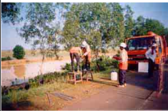
RN6-2 (Sta.52km+479) 雨季現場状況、洪水位が路面から約5m下まで上昇している。
