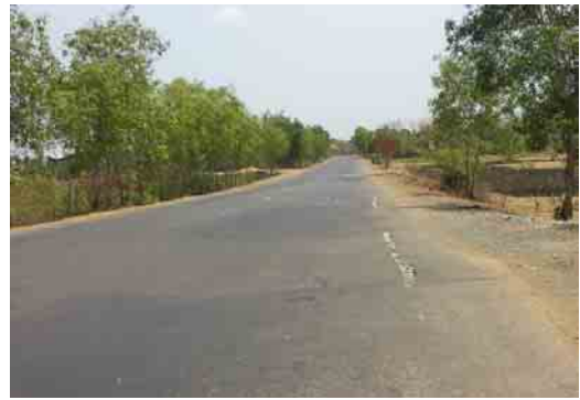
写真 2.1.4 軟弱地盤部の波打つ舗装
