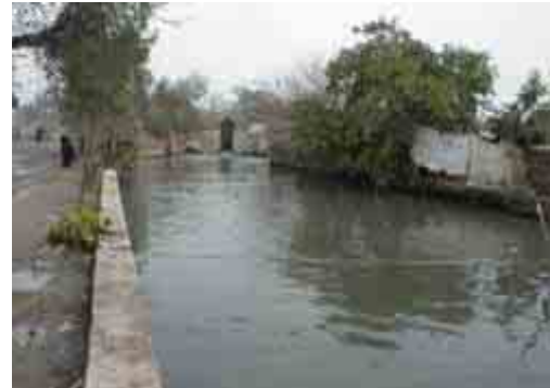
ラホール市内排水路
